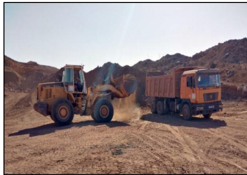
Figure 41 : roulage par camions de type « dumper »
