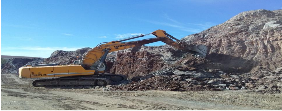
Figure 40 : Extraction par une pelle hydraulique
