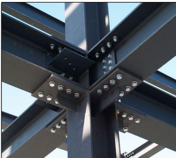
Figure 205 : assemblage poutre- poteau. Source : www.pinterest.fr/
