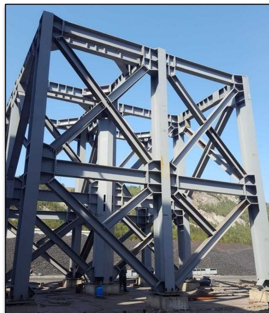
Figure 214: contreventement d'une structure Source : Pinterest
