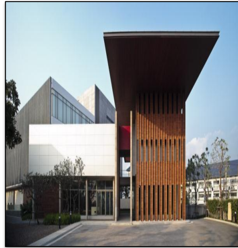
Figure 101 : Centre d'archives royal Source : https://www.arch2o.com/
