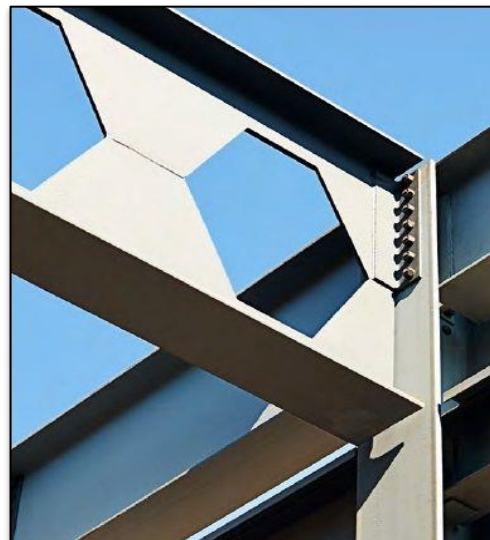
Figure 206 : assemblage poutre- poteau. Source : www.pinterest.fr/
