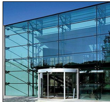
Figure 235 : mur rideau sur façade
