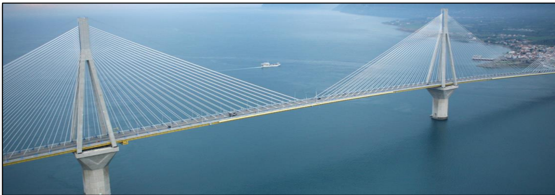
Figure 227 : Pont Rion-Antirion . Source : www.google image.com
