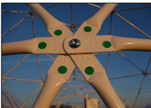
Figure 217: connecteur du dôme géodésique.
