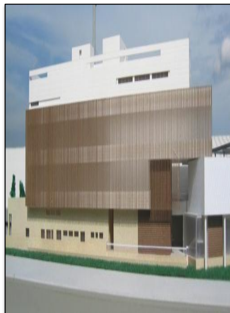
Figure 105 : Façade du centre d'archive royal Source : https://www.archdaily.com/
