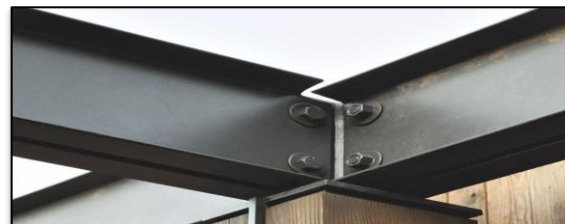
Figure 202 : assemblage poutre- poutre Source :http://imagesdubtp.iutrs.unistra.fr/picture.php?/18810
