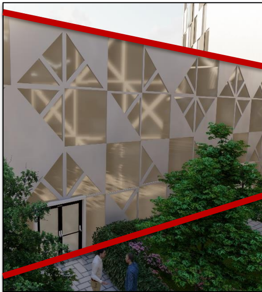
Figure 229 : façade en ciment biodynamique dans notre projet.
