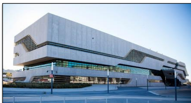
Figure 91 : Archives départementales de Hérault ‘Pierresvives’ Source : https://www.archdaily.com/
