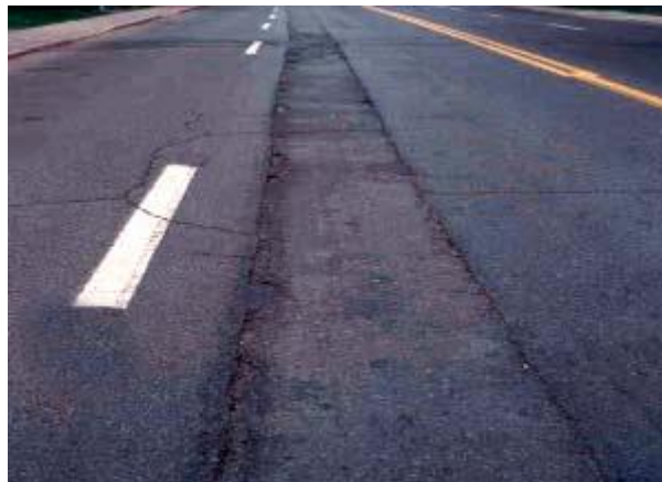
Figure III.20 : Coupe et tranchée sur les routes.
