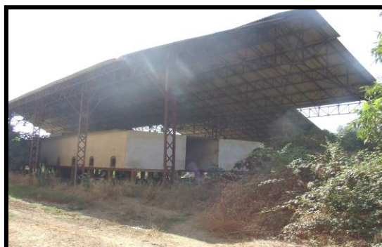
Photo 4. 4: les cuves à vin
