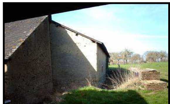
Photo 3.24: Façade Est du bâtiment B
