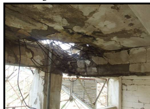
Photo 4.121: Réfection de la poutre par bétonnage
