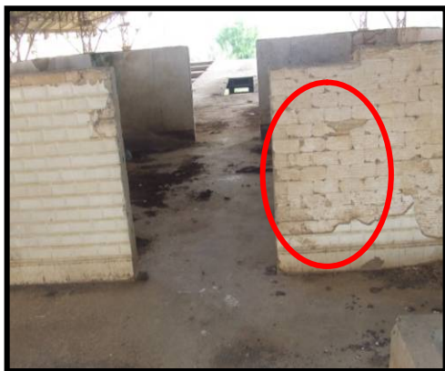
Photo 4.72: Revêtement altéré
