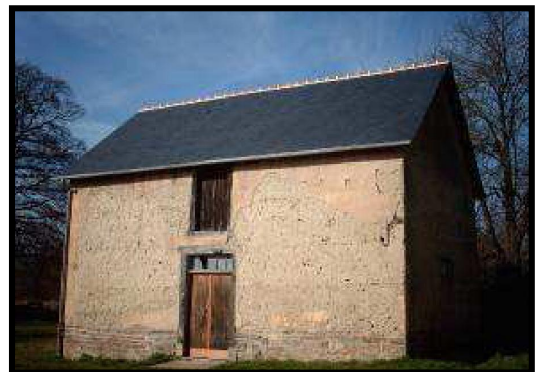
Photo 3.26 : Façade Est du bâtiment C
