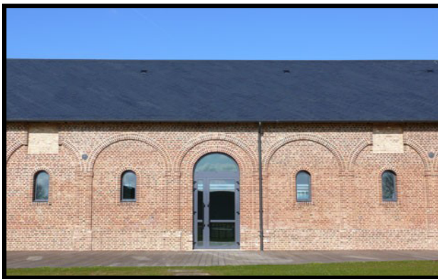
Photo 3.13: Façade rythmée par les arcades
