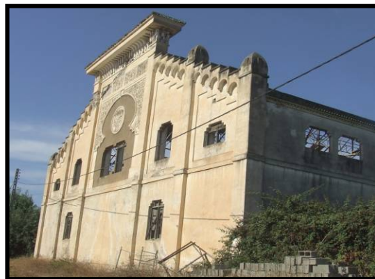
Photo 4.14 : Façade latérale de la cave
