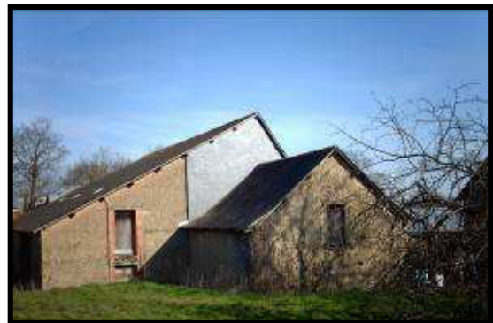
Photo 3.22 : Façade Ouest du bâtiment B
