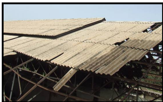
Photo 4.26: Module de plaques d'Eternit
