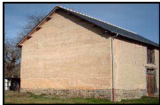
Photo 3.28 : Façade Sud du bâtiment C
