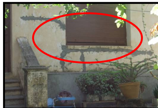
Photo 4.114: Fissures colmatées
