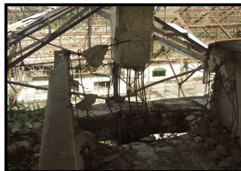
Photo 4.120 : Réfection du poteau par bétonnage
