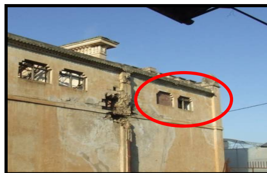
Photo 4.82: Fermeture des ouvertures avec de la brique
