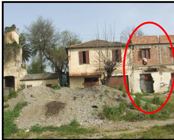
Photo 4.15: Nouvelle construction adossée à l'ancienne maison du comptable
