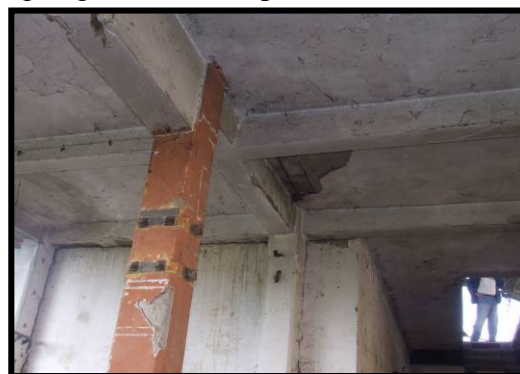
Photo 4.119 : Réhabilitation du béton par ragréage
