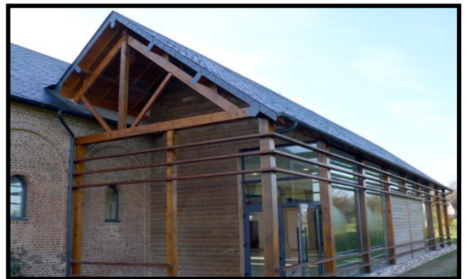
Photo 3.14 : la nouvelle extension
