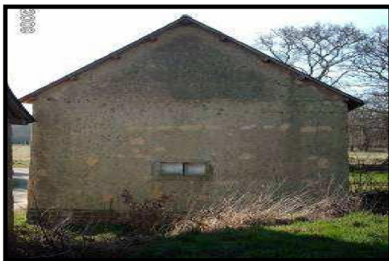
Photo 3.27 : Façade Nord du bâtiment C
