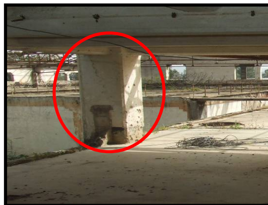
Photo 4.17: Système constructif poteau-poutre en béton armé
