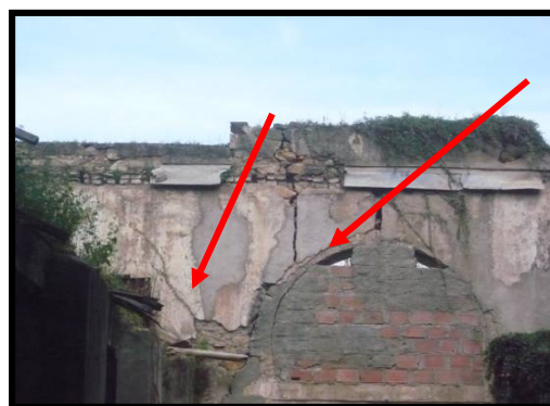
Photo 4.96: Renforcement par remplissage
