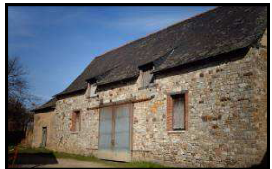
Photo 3.19 : Façade Sud du bâtiment B
