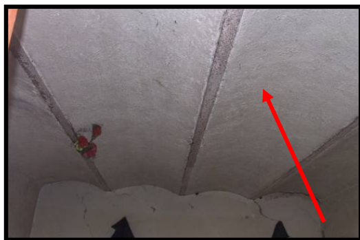
Photo 4.24 : Plancher en voutain
