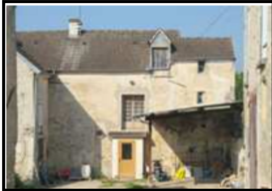
Photo 2.3: ferme à corps de bâtiment unique le bloc en hauteur.
