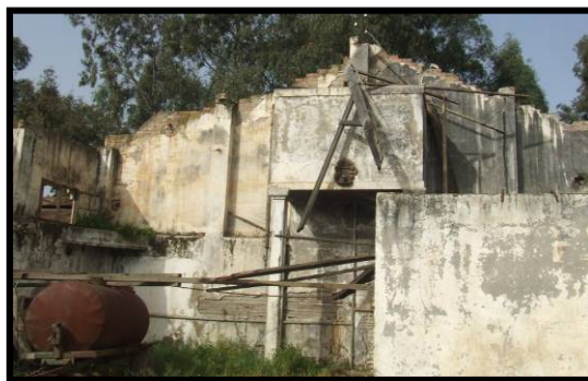
Photo 4.58: château d'eau qui approvisionne l'écurie
