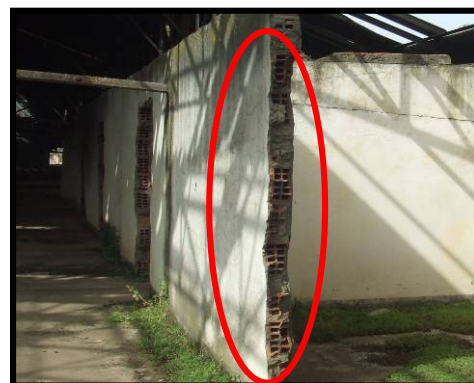
Photo 4.22: Remplissage en brique
