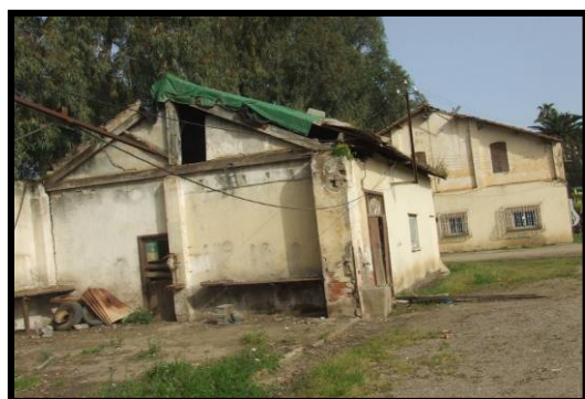
Photo 4.45: Toiture délabrée
