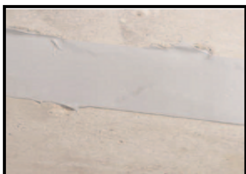
Photo 4.122: Calfeutrement des fissures à l'aide d'un mastic à base de liants organique
