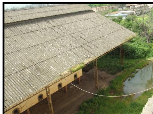
Photo 4.70: Une partie des modules de la toiture est en bonne état
