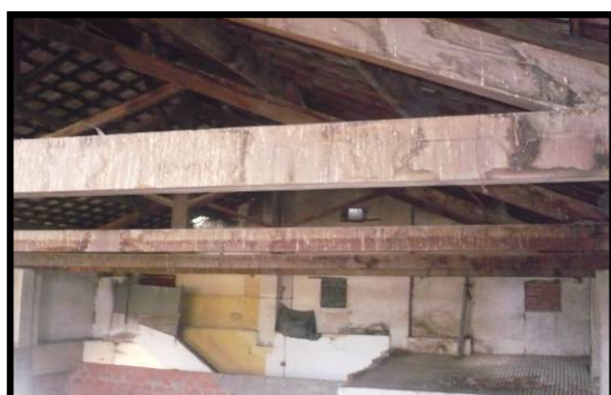
Photo 4.28: Charpente en bois avec tuile (fermes)
