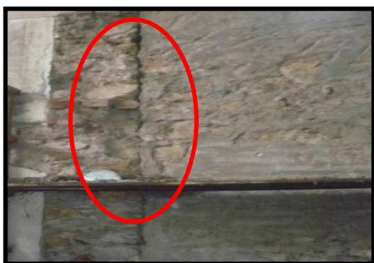
Photo 4.18: Système constructif mur-porteur
