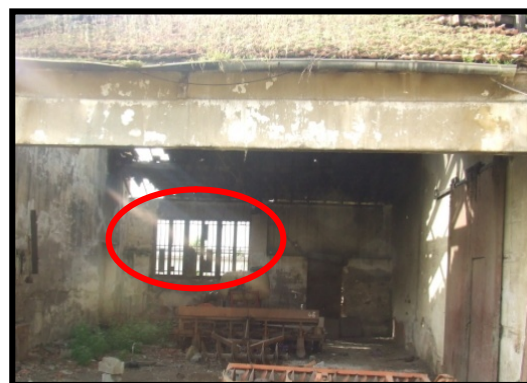
Photo 4.54 : Fenêtre endommagée
