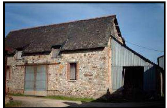
Photo 3.18 : Façade Nord du bâtiment B
