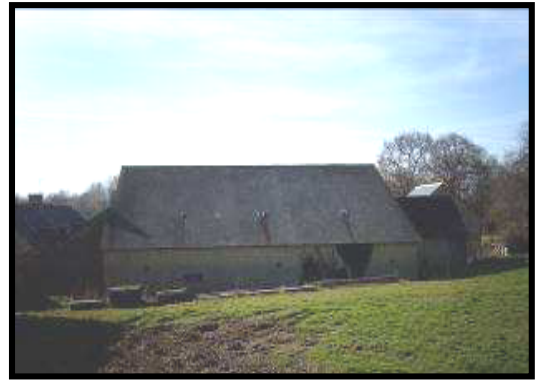
Photo 3.20: Façade nord du bâtiment B
