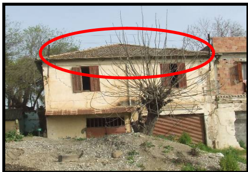
Photo 4.89: Une partie de la toiture est en bon état
