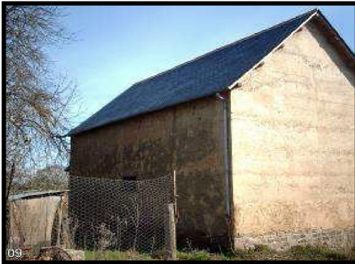
Photo 3.25 : Facade Ouest du bâtiment C
