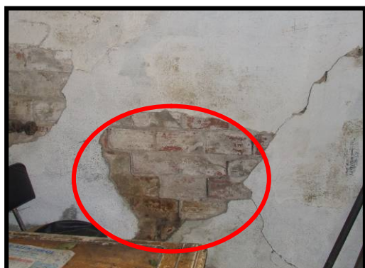
Photo 4.21: Remplissage en brique
