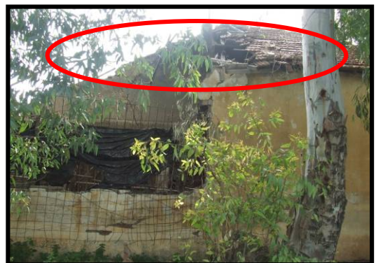
Photo 4.50: Toiture écroulée
