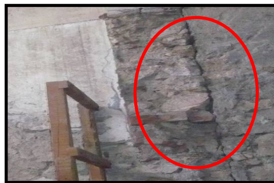
Photo 4.20: Remplissage en pierre-mortier
