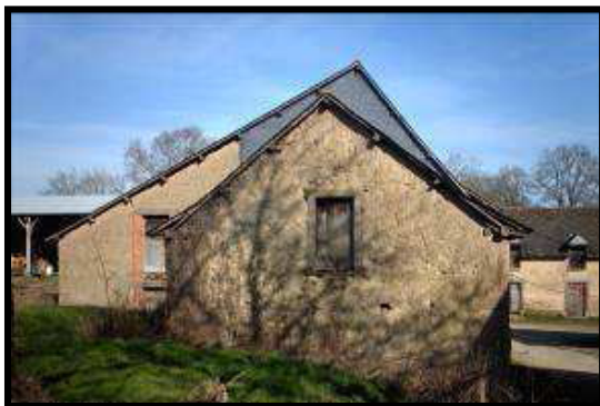
Photo 3.21: Façade Ouest du bâtiment B
