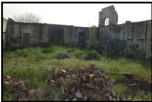
Photo 4.57 : La toiture est complètement détruite
