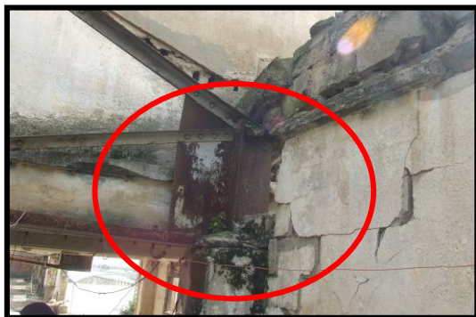
Photo 4.30: Ferme métallique posée sur le mur
