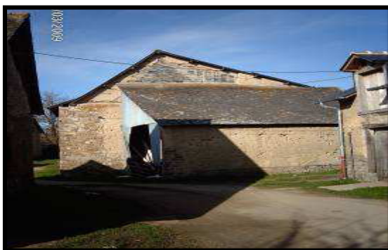
Photo 3.23 : Façade Est du bâtiment B
