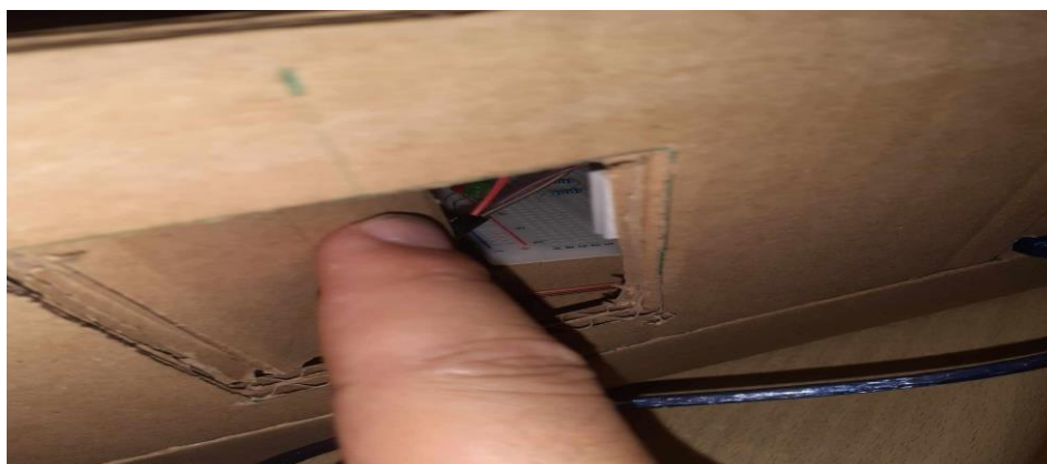
Figure IV.9 : accès par fenêtre séparation de capteur magnétique
