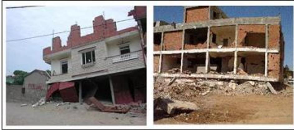
**Figure I.4 :** Destruction des rez de chaussée due à la flexibilité.
