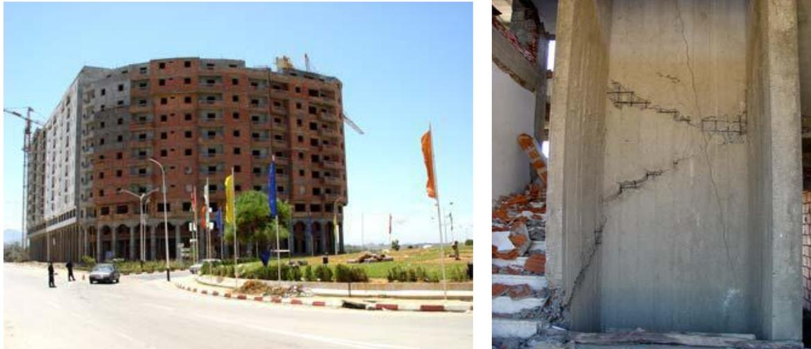
**Figure I.51 :** La présence des voiles en béton armé au droit de la cage d'ascenseur comme noyau central a certainement sauvé le bâtiment de s'effondrer. [13]
