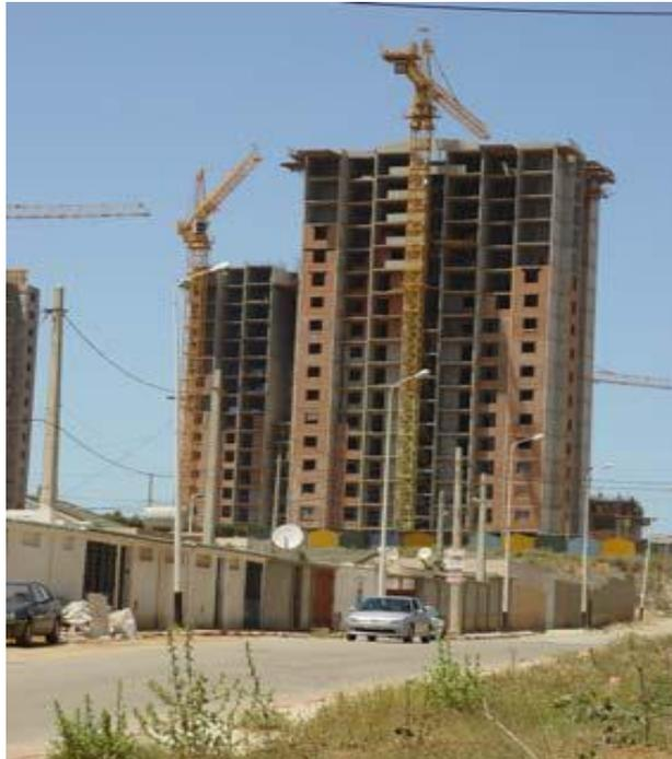
**Figure I.29 :** Bâtiment en cours de construction avec voiles en B.A, très bonne résistance à l'action sismique. [13]
