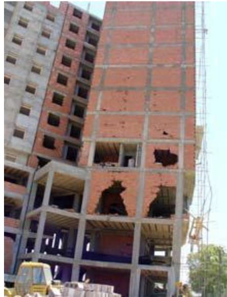
**Figure I.48 :** Bâtiment à contreventement mixte en cours de construction dans la sauvegarde est dû à la présence des cages d'ascenseur en béton armé. [13]
