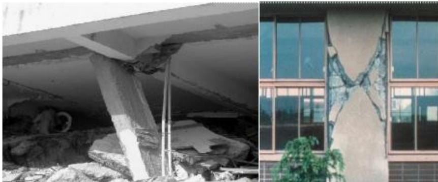
***Figure I.2 :*** Cisaillement des poteaux.
