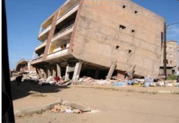
***Figure I.1 :*** Irrégularité en élévation et effondrement de la structure sur le RDC. [13]
