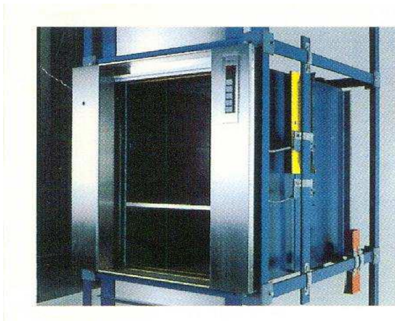
Figure I.4: Les deux portes palières montées à l'intérieur de la gaine [2].
