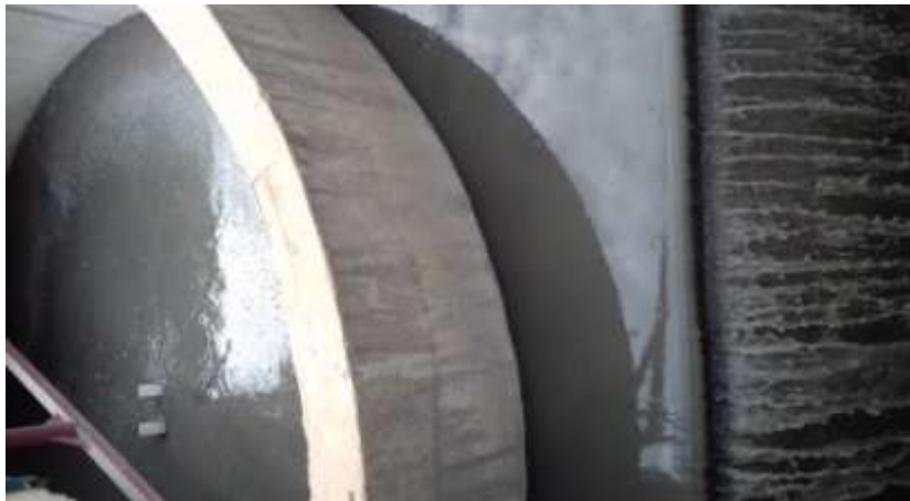
Figure15. Bassin de décantation.
