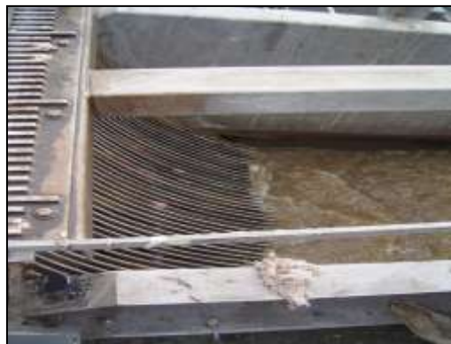
Figure 8. Lamelles de dégrillage (Belbachir et Habbeddine ,2017).
