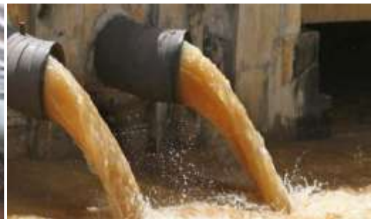
Figure 4.Ecoulement des eaux dans la STEP (ONU, 2018).
