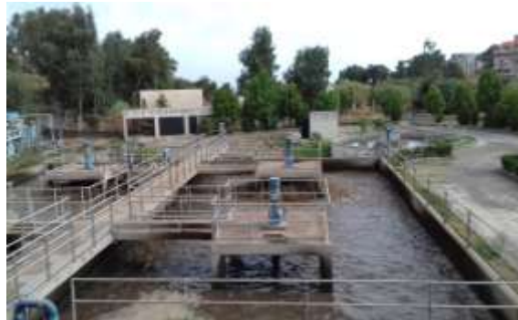
Figure20. Bassin d'aération.
