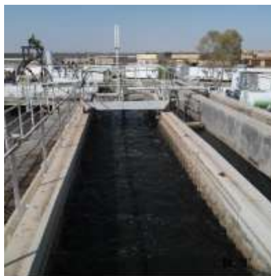
Figure 9. Dessablage-déshuilage (Sichi et Rezzoug ,2017).
