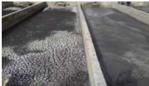
Figure27. Lits de séchage.
