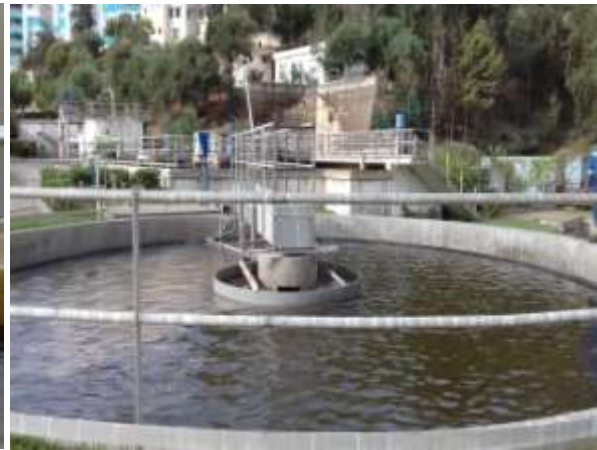
Figure23. Clarificateur.
