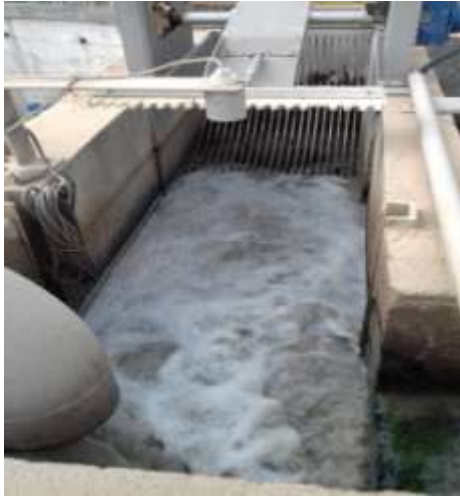
Figure16. Degrilleur fin.
