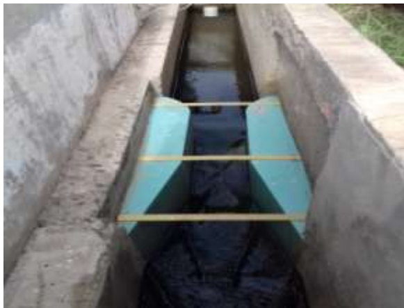
Figure24. Canal venturi.
