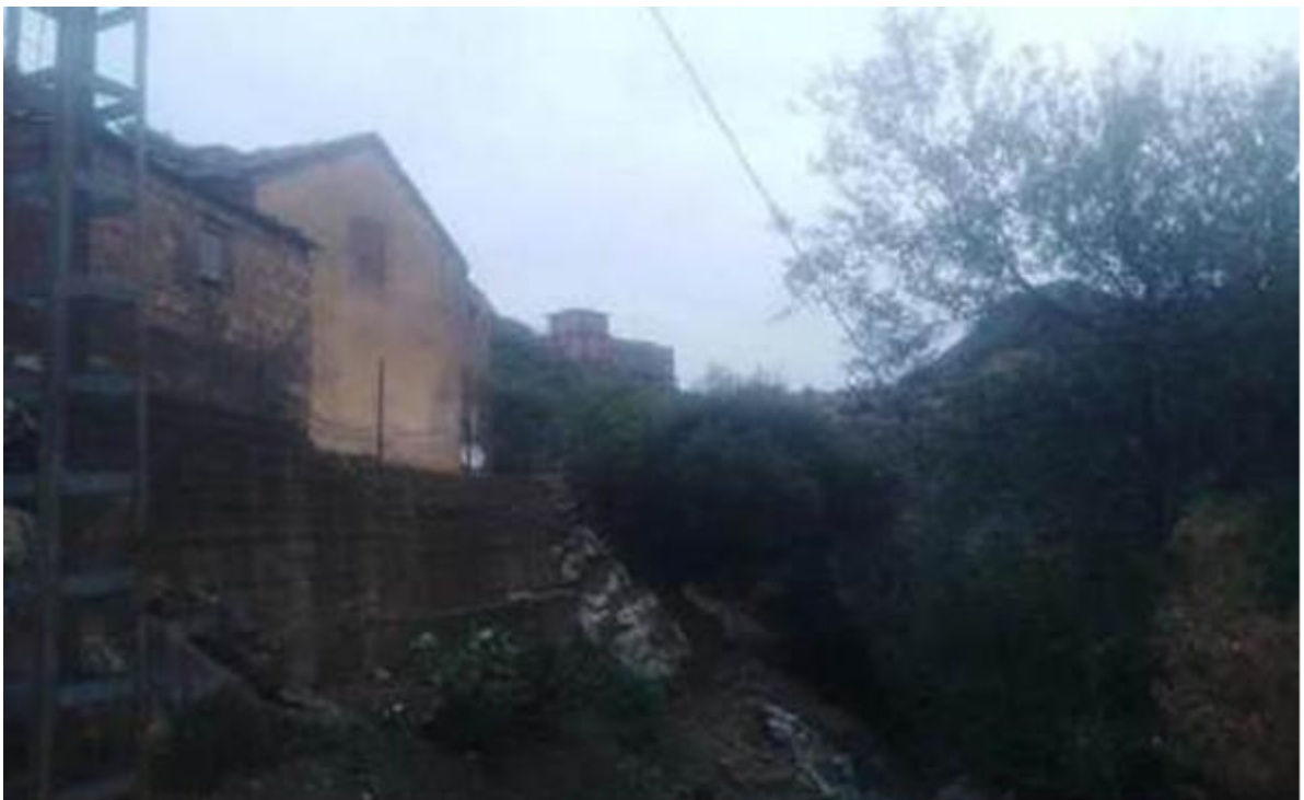
Image 26 : Une maison traditionnelle habitée par un villageois d'Aït Irane M. M. Chabane. Prise 09 septembre 2024.
