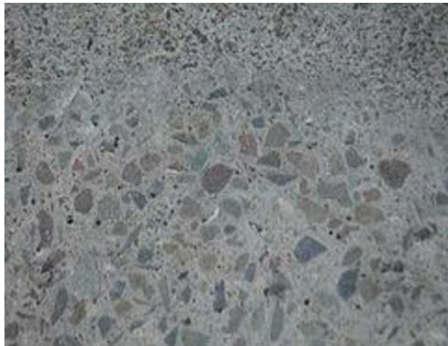
Figure I.3 : le matériau béton [4].
