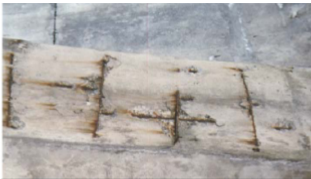
(a) carbonatation d'une pièce de structure
