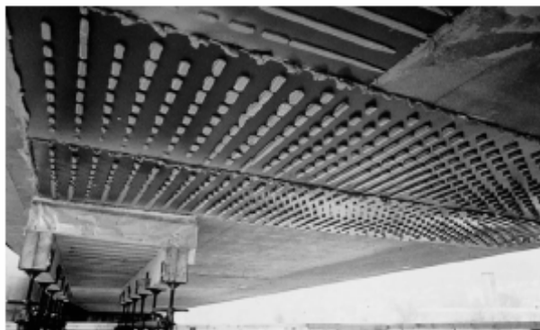
Figure I.8. Renforcement d'un viaduc par tôles collées
