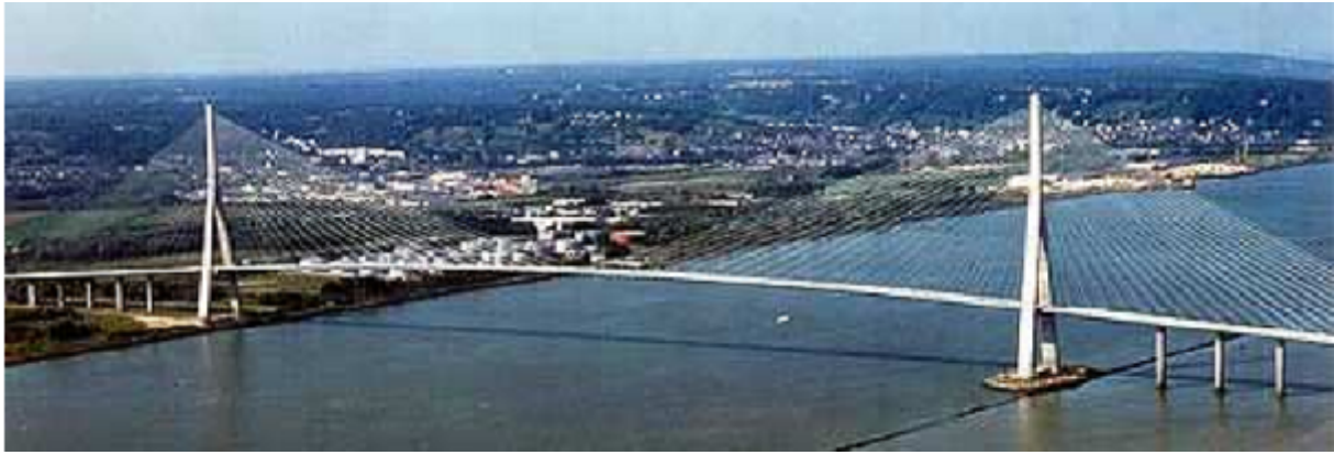
Figure I.1. Pont de Normandie avec 856 mètres de travée centrale. I – Etude bibliographique
