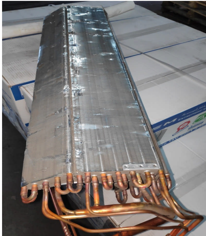
Fig. (III.9) : Evaporateur d'un climatiseur split système 24000btu/h.
