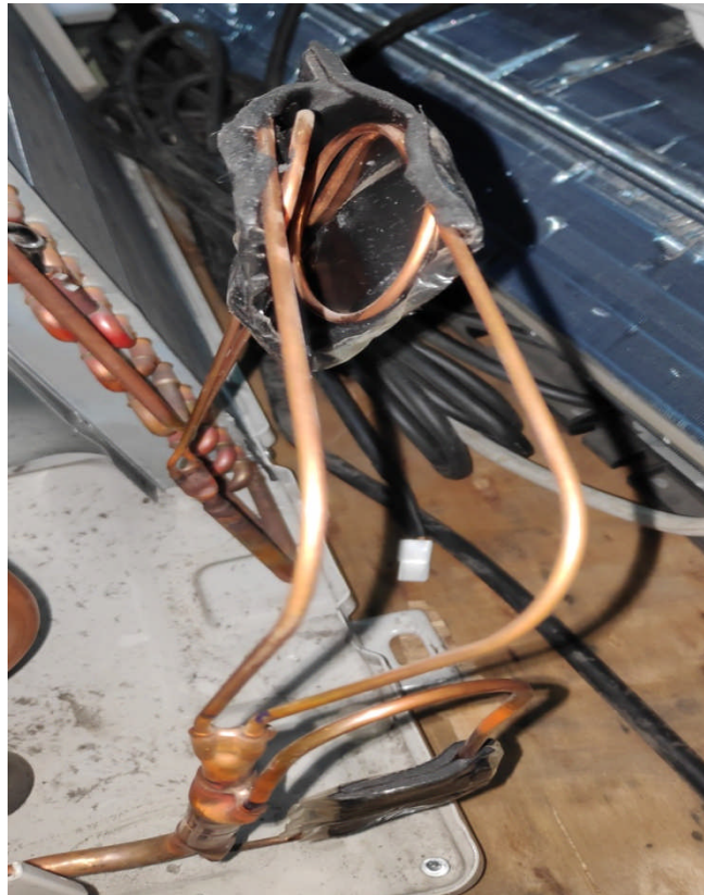
Fig. (III.8) : Détendeur d'un climatiseur split système.
