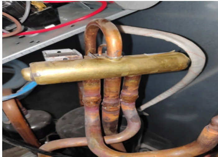
Fig. (III.11) : vanne 4 voies d'un climatiseur split système.
