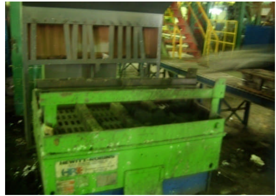
Fig. II.1.6 : Poste de démoulage
