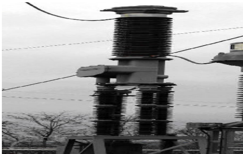
Fig. (III.10) : Disjoncteur a huile
