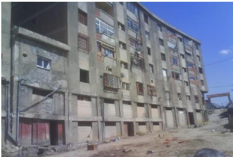
Fig.2 -7- : Les constructions des années 1990.
