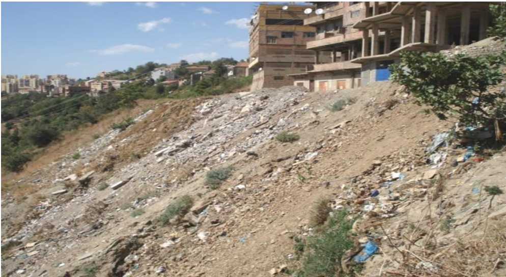
Fig.3.3 : Construction sur des remblais récents.
