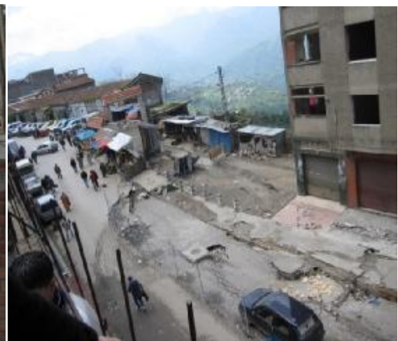
Fig.2-16 : Avril 2009 les bâtiments 15,14 et 19 Évacués.
