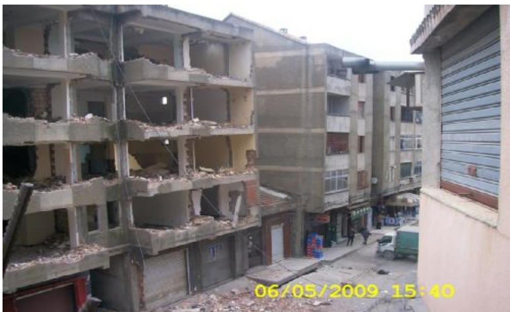
Fig.2 -9 : Démolition des structures.
