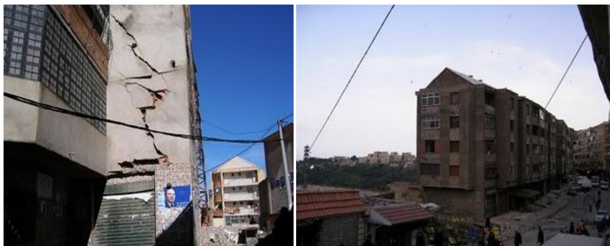
Fig.3.2 : Les Constructions de la zone rouge.
