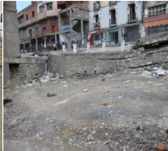
Fig.2.12- : Situation de cette zone en 2009 (Avril /2009)
