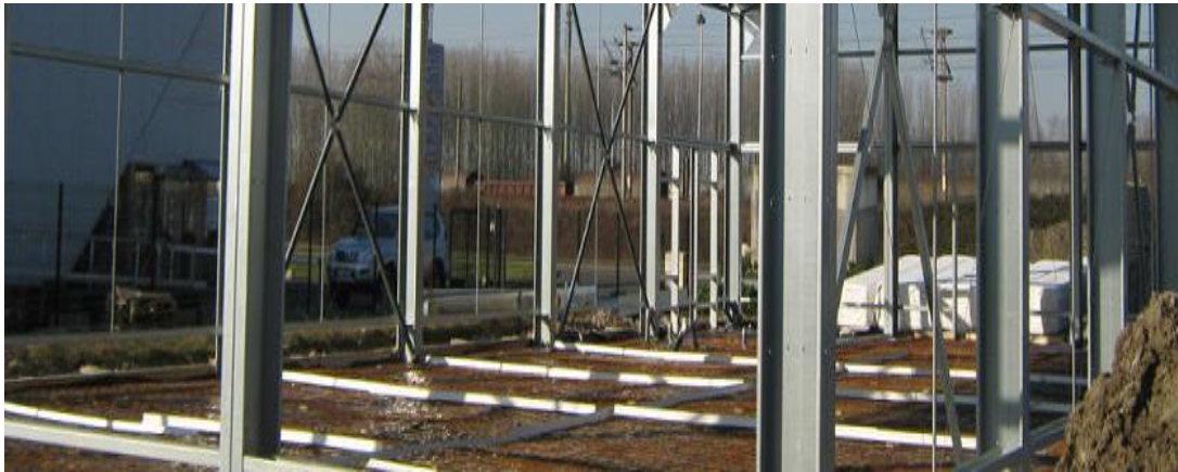
Figure2. Exemple de poteau en acier HEB
