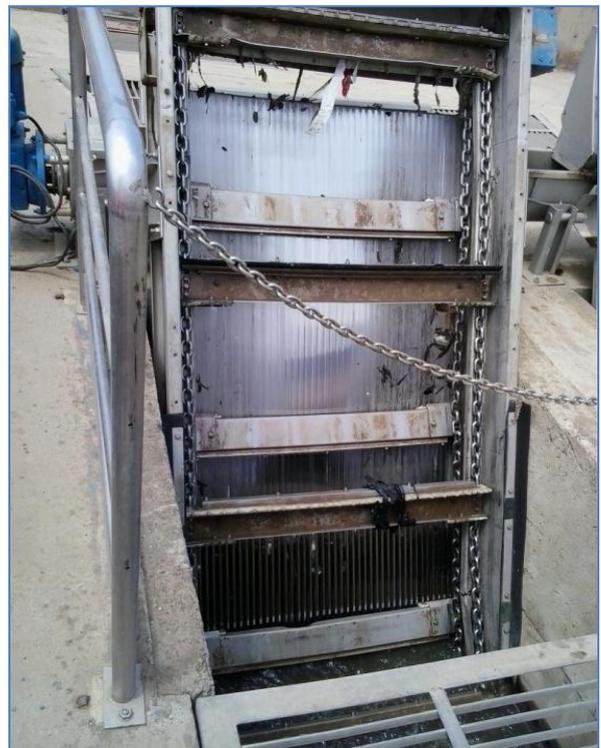
Figure II-3 : le Dégrillage
