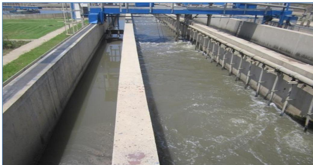
Figure II-4 : le dégraissage
