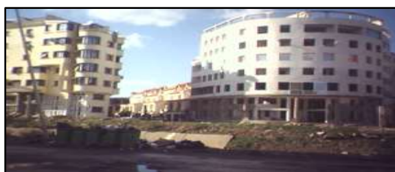
Figure 42 : Cité 24 Février Source : Cliché Auteurs
