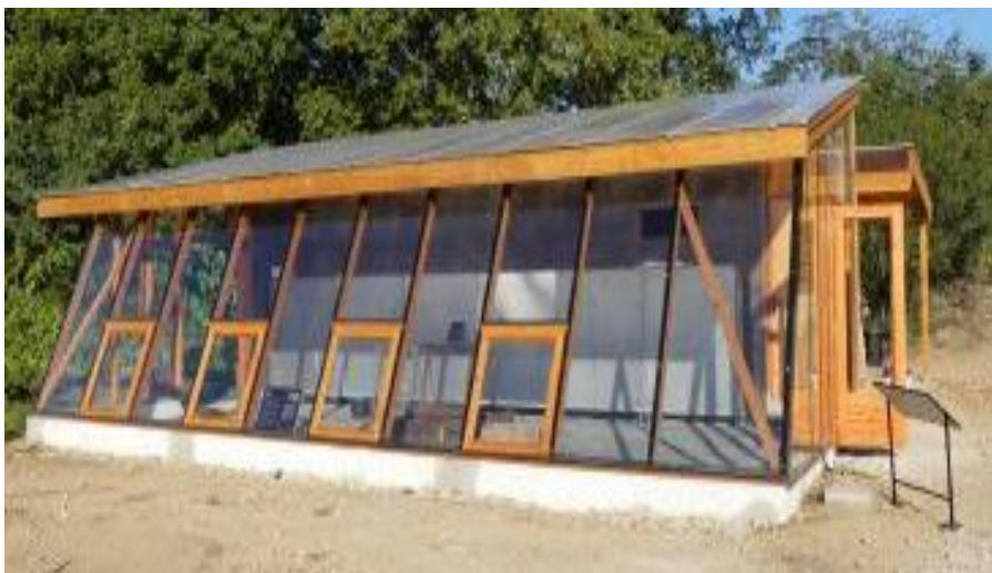
Figure 19: Utilisation du vitrage vertical dans une serre bioclimatique. Source : Programme de recherche et développement sur les serres maraîchères bioclimatiques et mobiles
