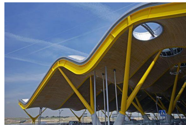
Figure 169: Les poutres de l'AÉROPORT DE MADRID BARAJAS, TERMINAL 4, PAR RICHARD ROGERS
