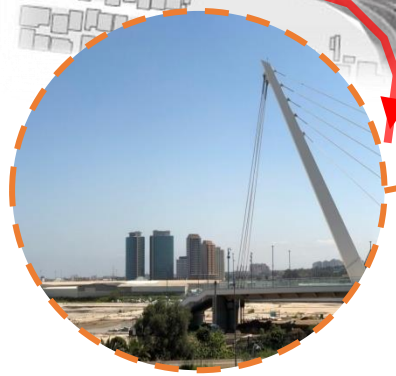
Figure 104 : Passerelle de la grande mosquée Source : Auteurs
