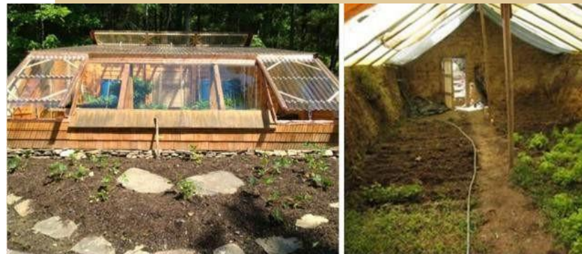
Figure 07 : Serre semi enterrée.
