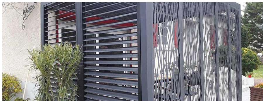
Figure 20: Utilisation des brises soleil dans la serre bioclimatique. Source: Programme de recherche et développement sur les serres maraîchères bioclimatiques et mobiles
