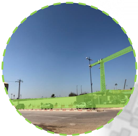
Figure 118 : Chantier, sources des nuisances sonore Source : Auteurs
