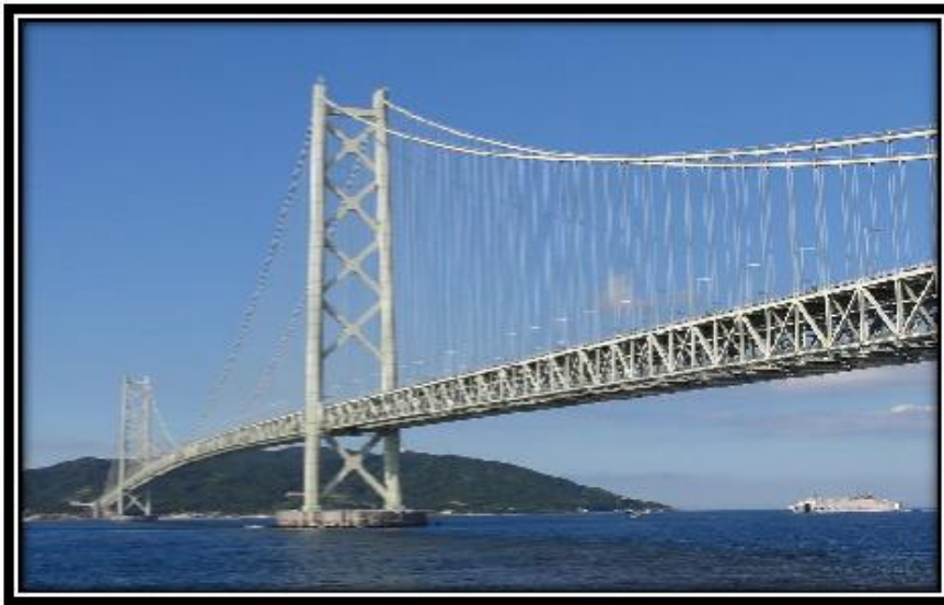
Figure I.3 : Le pont Akashi Kaikyo [9].
