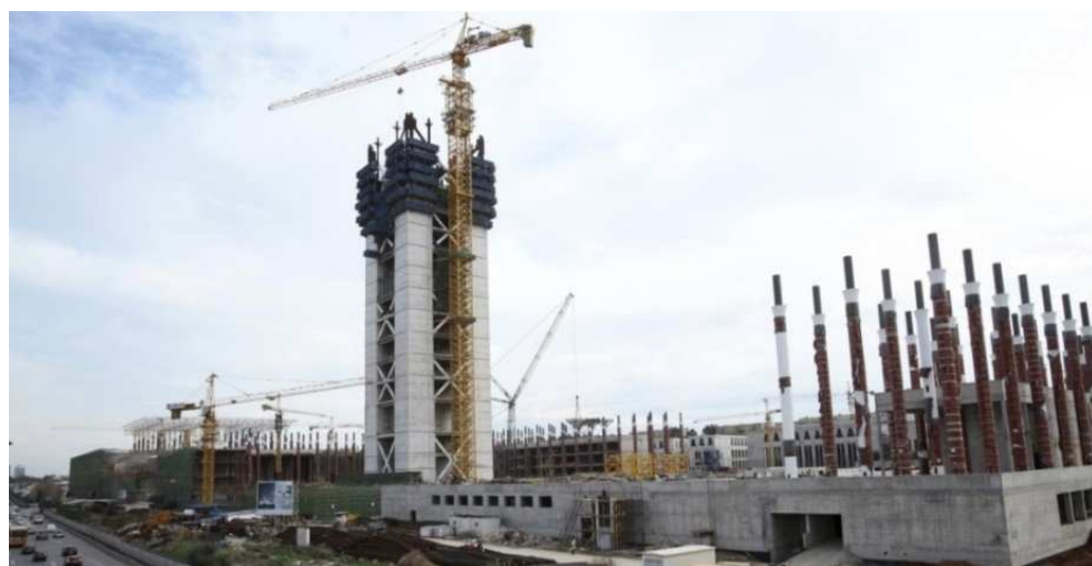
Figure II.11 : Contreventement par triangulation du minaret de la grande mosquée d'Alger (croix de Saint-André)
