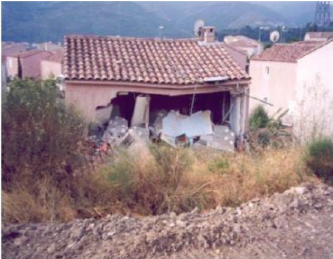
Figure IV.9 : Maison endommagée en pied de glissement de la Valantelle, à Marseille 2001. Source: www.brgm.fr
