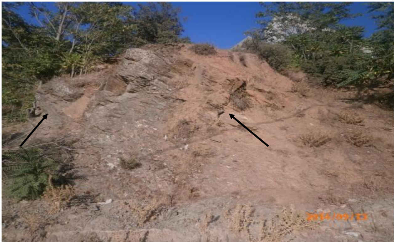
Figure V.10 : apparition des rochers à cause du glissement de terrain à Ain el Hammam, terrain qui es en dessous de la ville.
