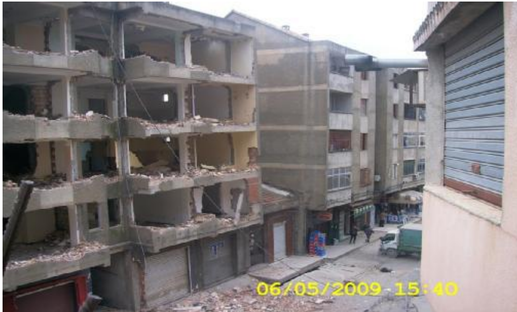
Figure V.1 : Démolition des structures. en mai 2009 source: thèse de kechidi zahia
