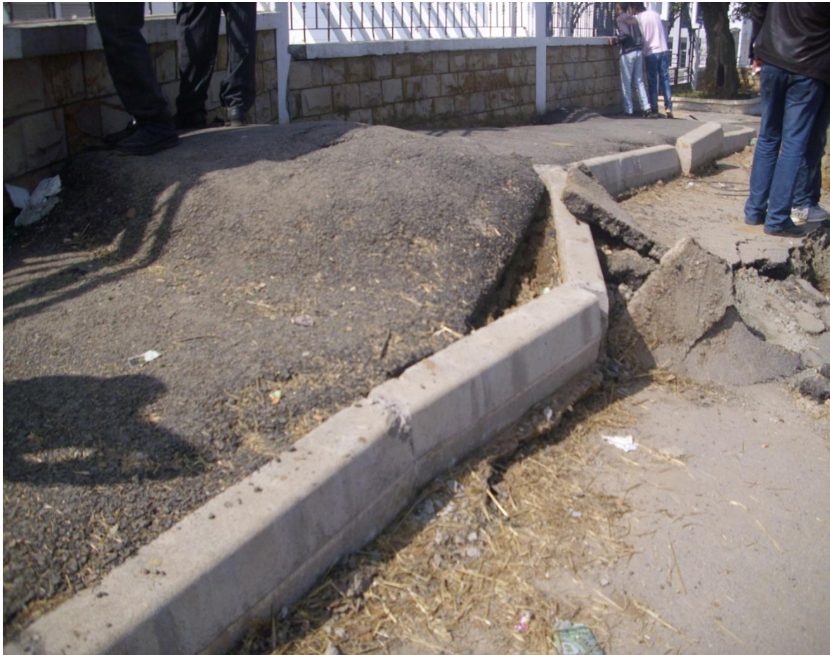
Figure III.3 : bombement sur le trottoir près du centre culturel à azazga Source: djerbal lynda, mars 2012
