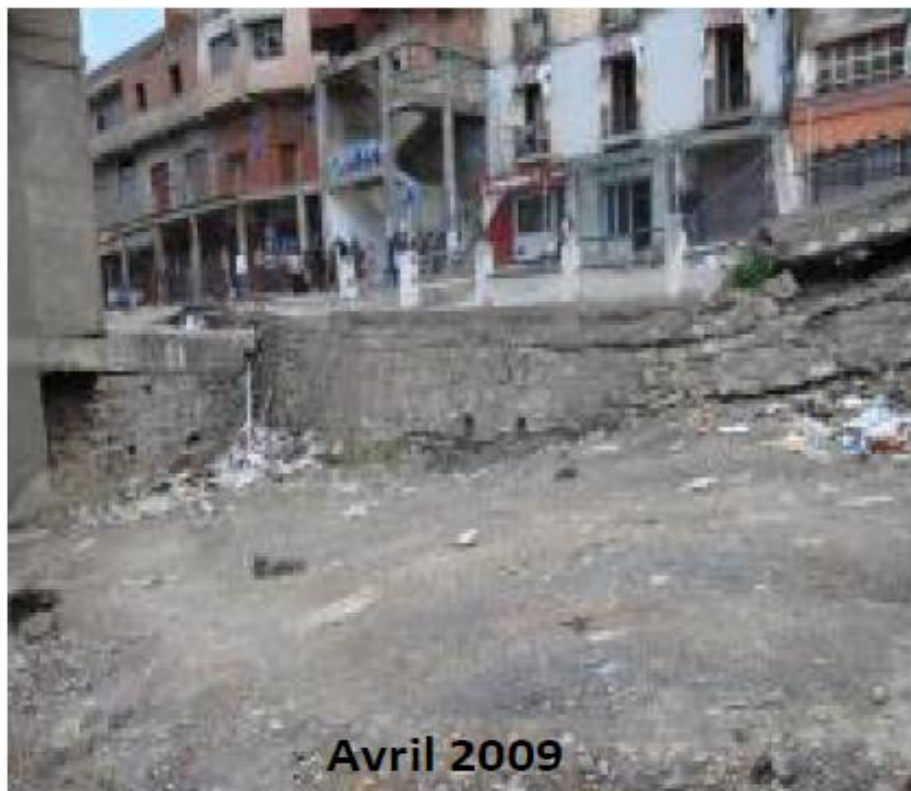
Figure V.28 : Mur de soutènement de la zone du marché. Source djerbal lynda
