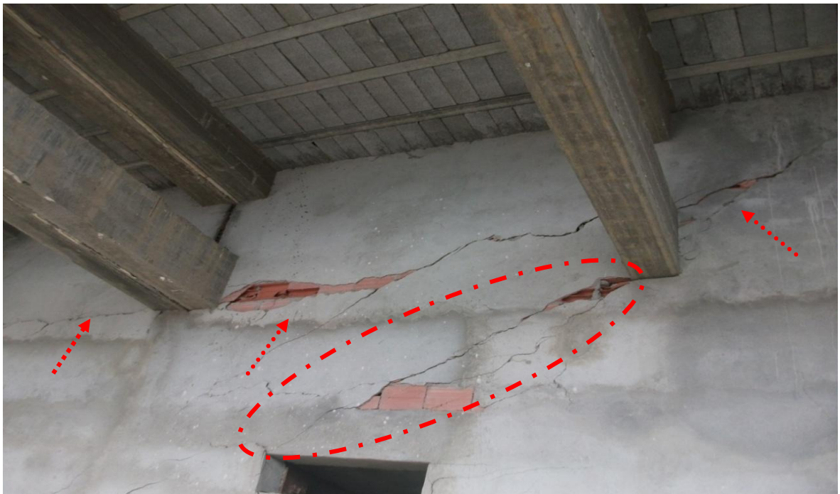
Figure V.20 : rupture des longrines de la cage d'escalier de la cité 80 logts à Ain el hammam, 2014
