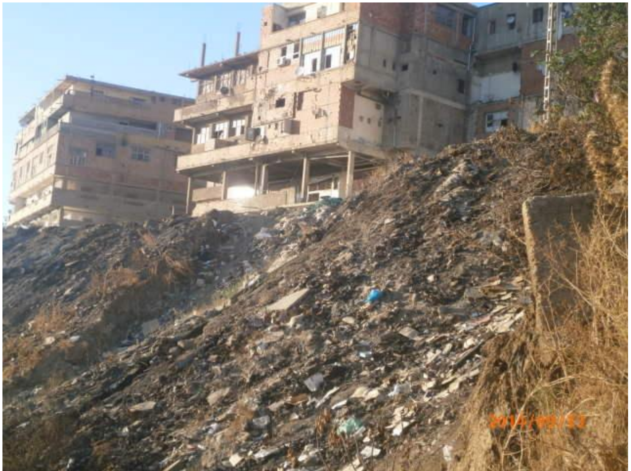
Figure V.16 : jet anarchique des remblais. Terrain qui se situe en dessous du marché, septembre 2014
