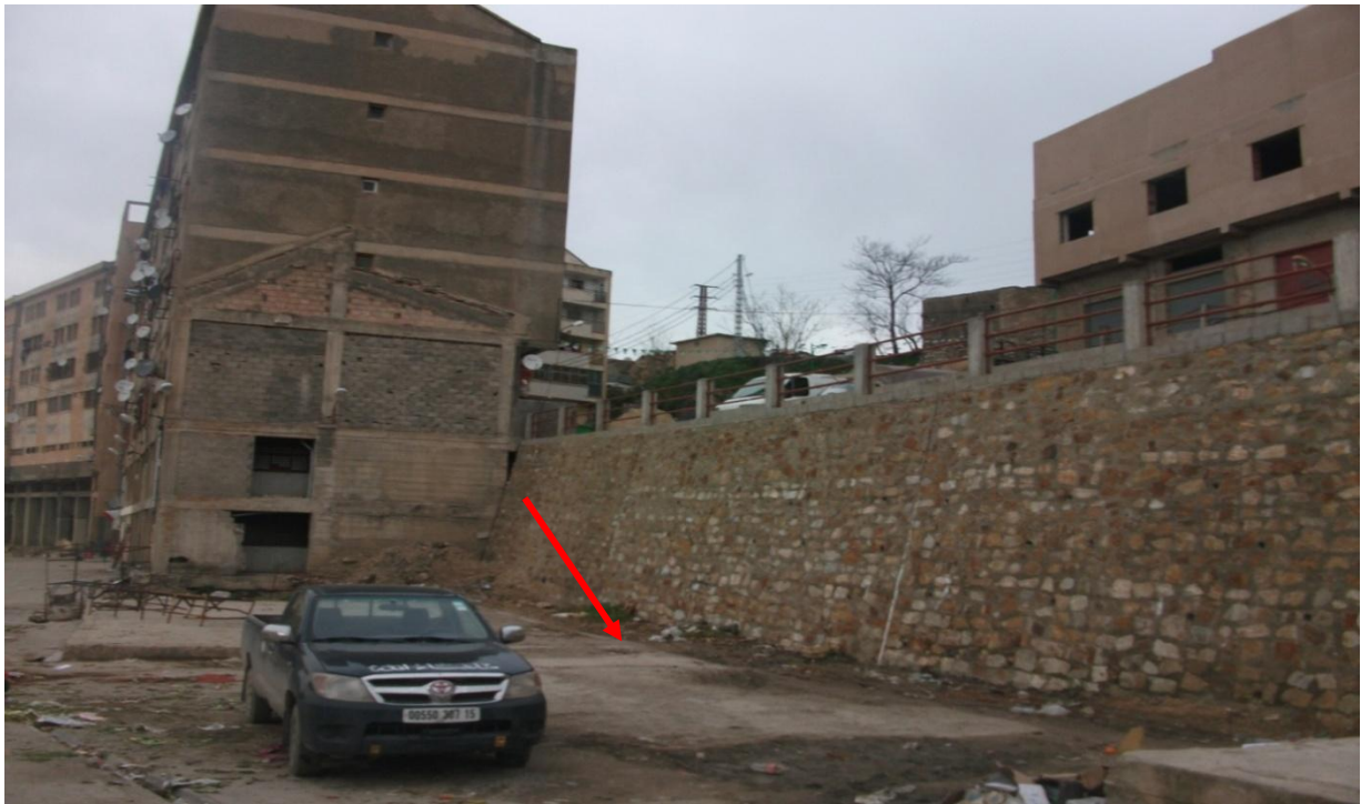
Figure V.8 : bombement de terrain du marché
