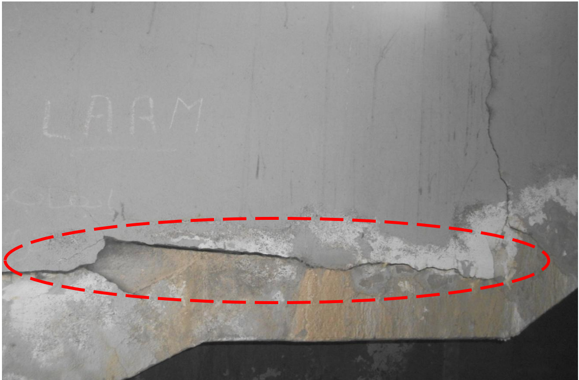
Figure V.20 : rupture des longrines de la cage d'escalier de la cité 80 logts à Ain el hammam, 2014
