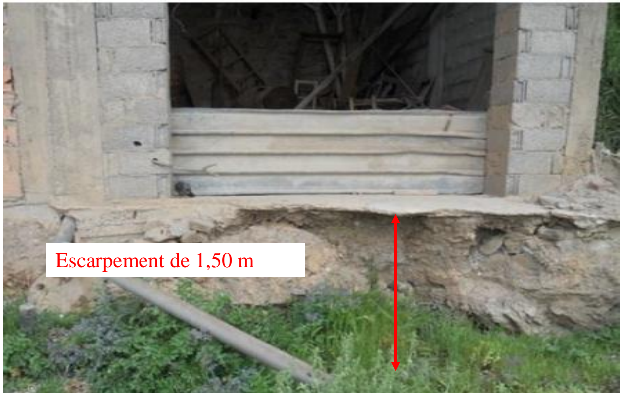
Figure V.6 : escarpement au niveau du mur de la menuiserie rue colonel amirouche
