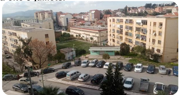
FIGURE 82 : VUE SUR LES FAÇADES TRAITE DES BARRES DE LA CITE CITE 5 JUILLET, SOURCE : TRAITE PAR LES AUTEURS .
