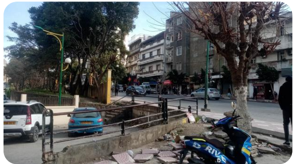
FIGURE 81: VUE SUR L'ESPACE ENTRE LA CITE 5 JUILLET ET L'AVENUE LARBI BEN MHIDI , SOURCE : LES AUTEURS .
