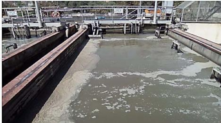
Figure 10. Déshuileage et dessablage fin (ONA,2022)
