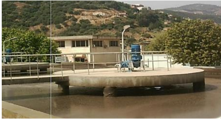
Figure 13. Bassin de stabilisation fin (ONA,2022)
