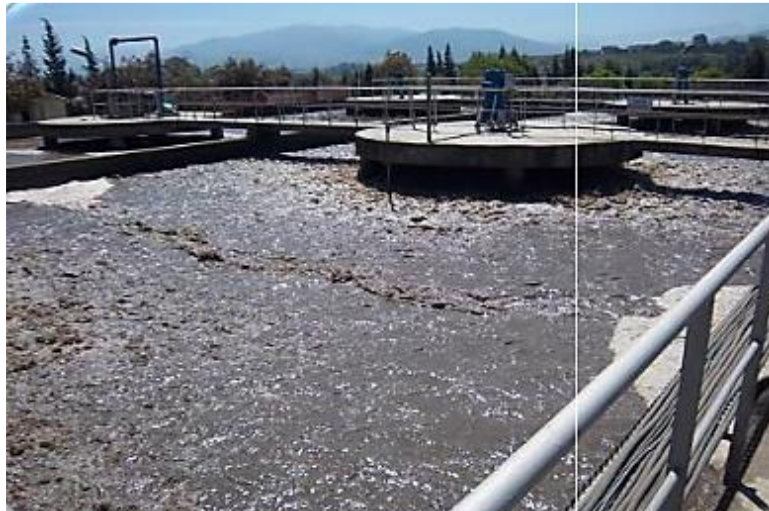
Figure 11. bassin d'aération fin (ONA,2022)
