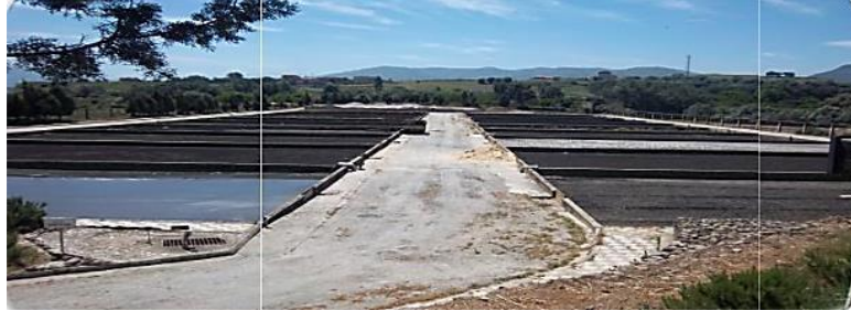
Figure 15. Lits de séchage fin (ONA,2022)
