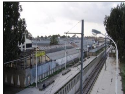
Figure I.10 : photo de la gare ferroviaire
