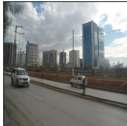
Figure I.28 : photos de la paroi du côté du quartier d'affaires. Source : les auteurs.
