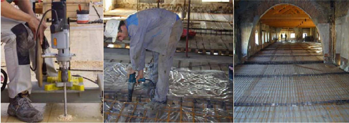
Fig.II.14 : Mise en œuvre des connecteurs SBB
