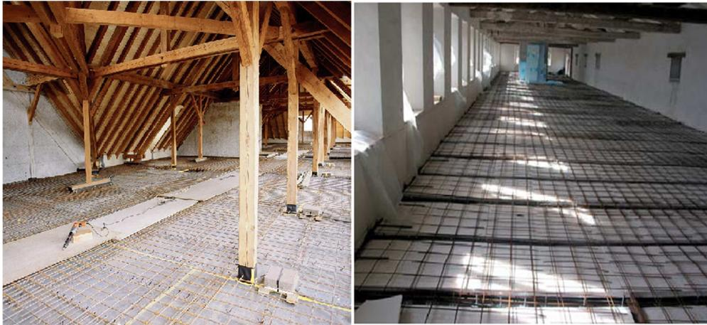
Fig. I. 3 : renforcement d'une structure par un plancher mixte.
