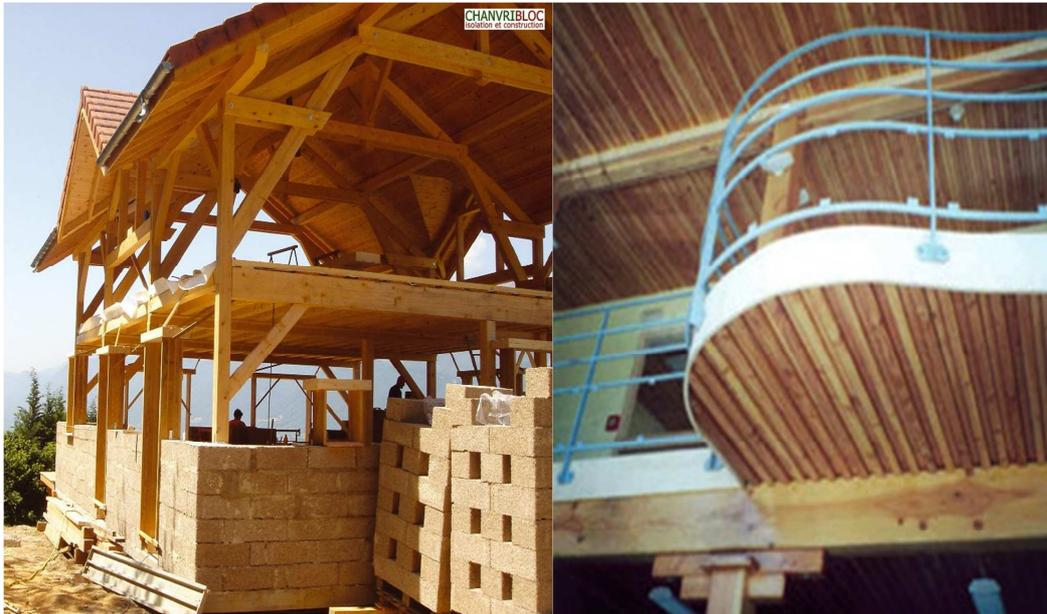
Fig. I .5 : Aperçue d'un plancher mixte pour une construction neuve.
