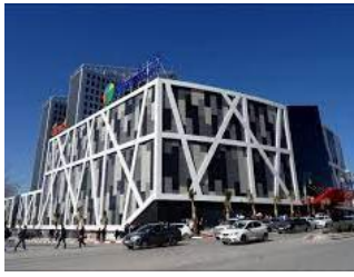
Figure 94: image du côté Est du Park Mall de Sétif /Source : Iliade Ingénierie (iliade-ingenierie.com
