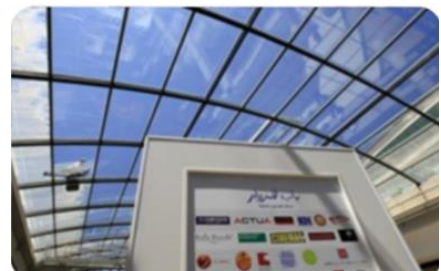
Figure 121: photo de l'atrium du centre commercial
