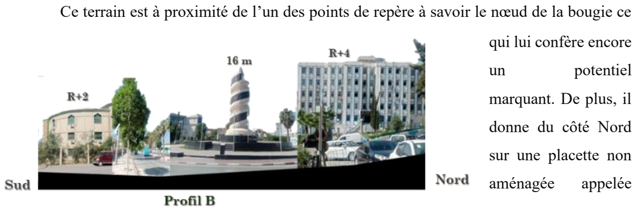
Figure 50: Profil B sur la rue des frères CHAFFA / Source : auteurs
