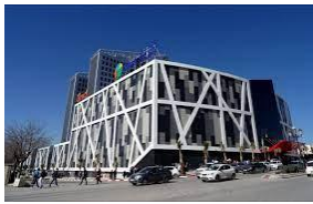
Figure 89: image du centre commercial en R+2 /Source : Iliade Ingénierie (iliade-ingenierie.com)
