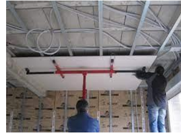
Figure 184: fixation d'un faux plafond sur rails métalliques.
