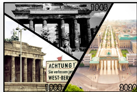
Figure 45: la porte de brandebourg en 1945, 1988 et 2020 Source : Traité par Auteurs 2021.
