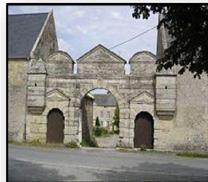
Figure 7 : Porte du château de Banvilleen-Villiers, pourvu d'une porte charretière et de deux portes piétonnes.
