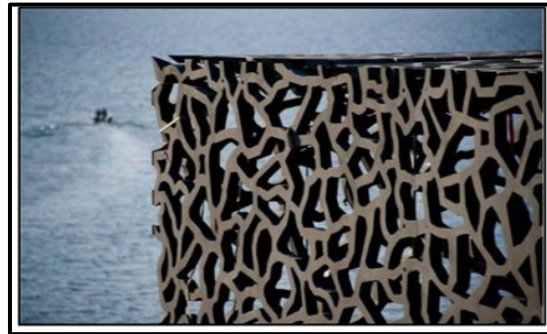
Figure 217 : Paroi perforée du MuCEM. Source : Marc Roudier
