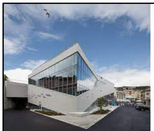
Figure 243 : centre culturel Plassen Source : www.Archdaily.com
