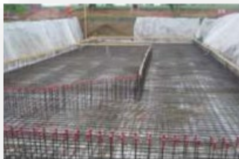
Figure 248 : Radier général Source : http:// www.cours-geniecivil.com
