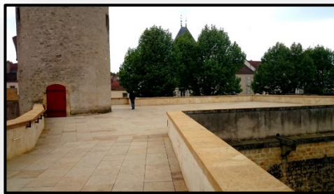
Figure 72 : la terrasse accessible Source : transvosges.wordpress.com
