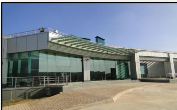
Figure 194 : vue sur la façade principale de l'incubateur Source : auteurs
