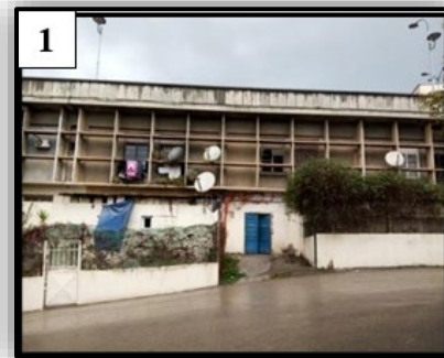
Figure 154 : immeuble de pont Source : Auteurs 2021
