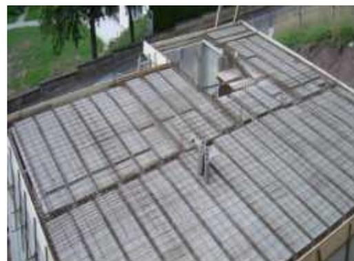
Réalisation d'un plancher à corps creux
