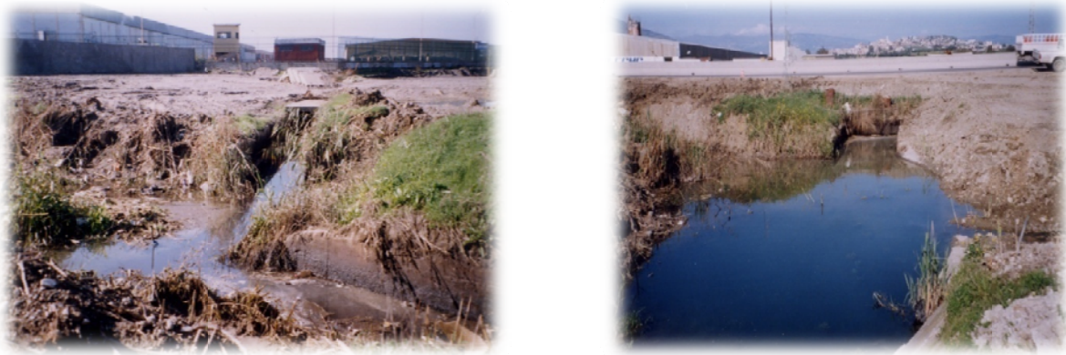
Figure 29: Vues du canal de sortie de l'ENIEM (ORIGINELLE, 2012).
