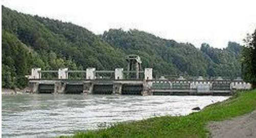
Les centrales hydroélectriques convertissent l'énergie potentielle de l'eau en énergie électrique. L'énergie provenant de la chute d'une masse d'eau est tout d'abord transformée dans une turbine hydraulique en énergie mécanique. Cette turbine entraîne un alternateur dans lequel l'énergie mécanique est transformée en énergie électrique.
