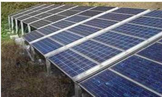
Ce mode de production d'électricité avec l'énergie solaire, utilise les rayonnements lumineux du soleil qui sont directement transformés en un courant électrique par des cellules assemblées en panneaux à base de silicium ou autre matériau ayant des propriétés de conversion lumière-électricité. Chaque cellule délivrant une faible tension.
