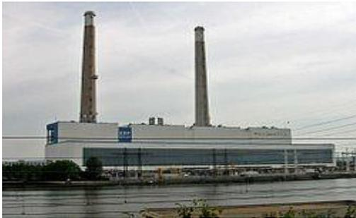
Une centrale thermique à flamme utilise l'énergie fournie par la combustion d'un combustible (charbon, pétrole, gaz naturel, gaz issus des hauts fourneaux). Cette combustion a lieu dans une chaudière.
