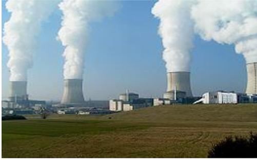
Ces centrales aussi utilisent le principe de la conversion thermodynamique, néanmoins leur chaudière est un réacteur nucléaire.
