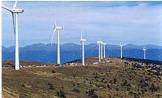
Dans une centrale éolienne, l'énergie électrique est produite directement par des génératrices éoliennes. Ces machines formées d'un **mat**, surmonté d'un générateur électrique entraîné par une hélice. Elles sont positionnées idéalement sur les plans d'eau ou des collines ventées. L'alternateur permet de transformer cette énergie mécanique en énergie électrique.
