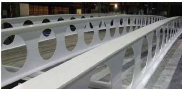
Fig. N°187: poutre alvéolaire
