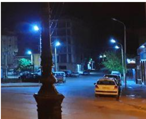
Image 19 : Luminaire LED à AZAZGA
