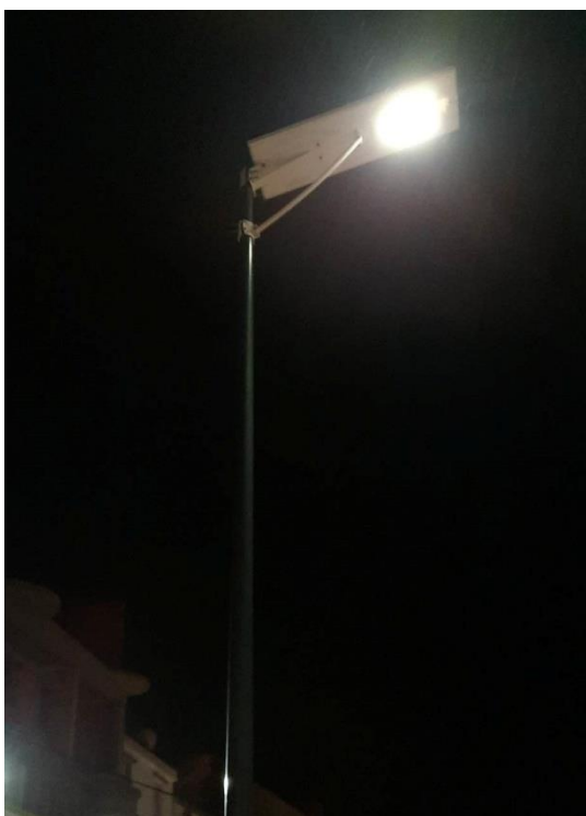
Image 20 : Luminaire LED panneau solaire à AZAZGA
