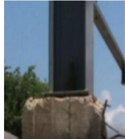
**Fig.119** : Liaison poteau béton armé- poteau . métallique. Source : www. archdétail.fr
