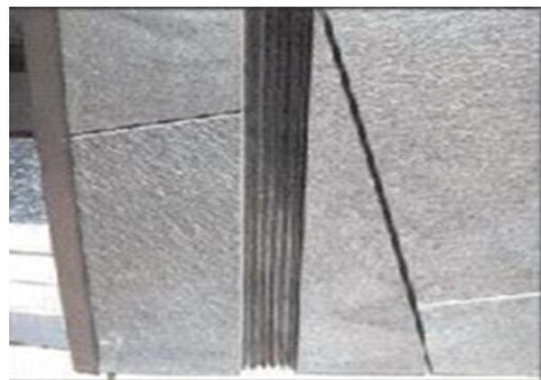
Fig.125 : couvre-joint à soufflet en caoutchouc
