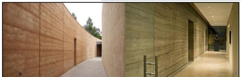
Figure (145) : Projet réalisés en terre stabilisée/Source : <http://www.agripo.net>
