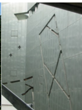
Figure 86 : façade de projet. Source : Google.
