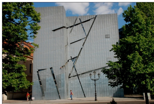
Figure 88 : façade du projet. Source : Google.
