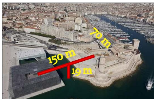
Figure 97: les deux passerelles. Source : auteur
