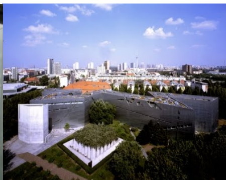
Figure 87 : vue d'ensemble sur le projet. Source : Google.
