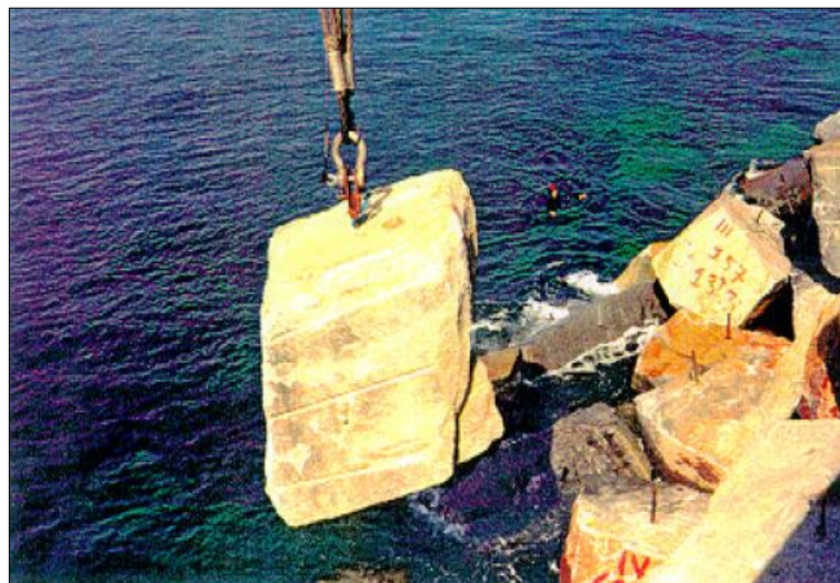
Figure IV.9. Mise en place d'enrochements sous la surveillance d'un plongeur.
