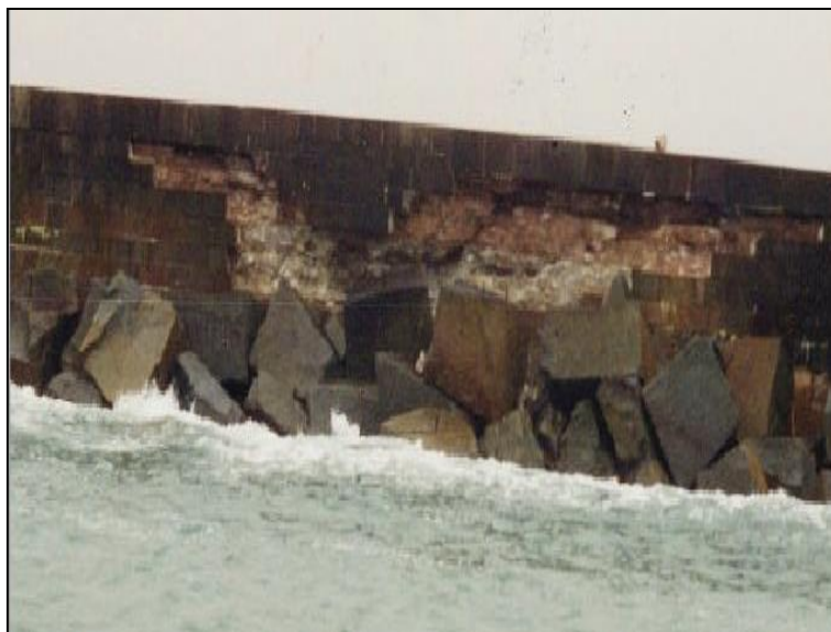
Figure IV.7. Dégarnissage du parapet.
