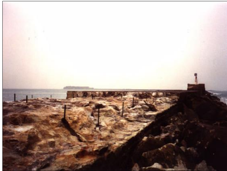
Figure IV.11. Réparation du couronnement de l'ouvrage.
