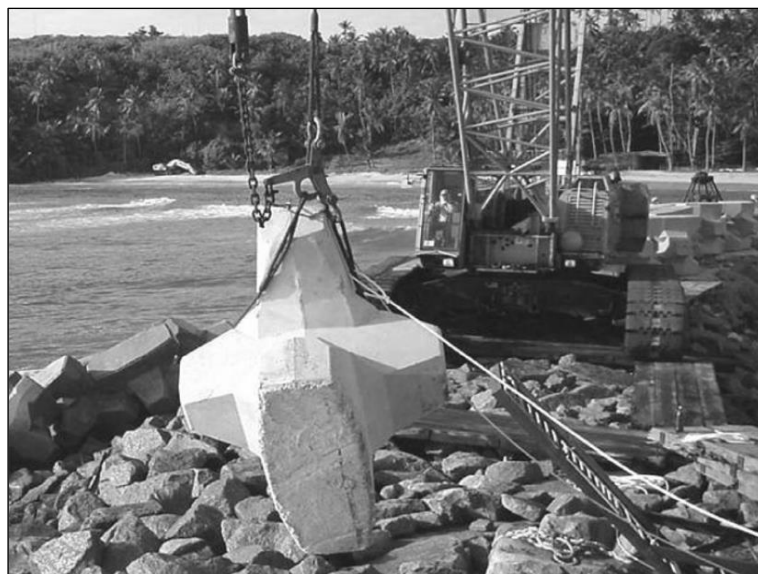
Figure III.5. Utilisation d'un crochet à ouverture rapide.
