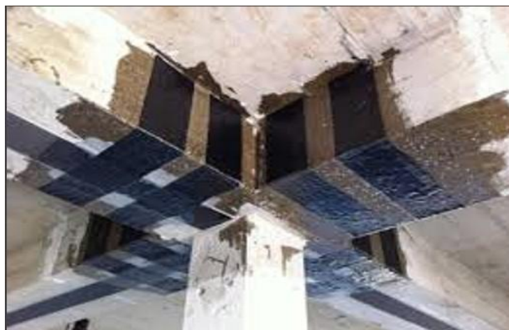
Figure I.7 : Renforcement des poutres par matériaux composites.
