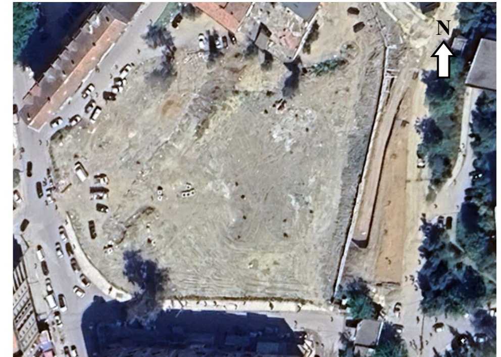
Figure 34: carte présente l'état environnementale de l'assiette après nettoyage (janvier 2025)
