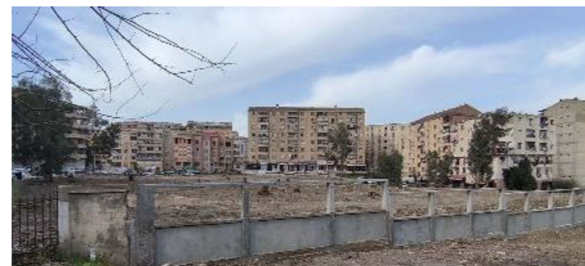
Figure 31: Vue sur le mur du côté Est de l'assiette.
