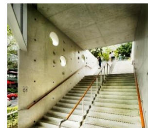
Figure 73: Escalier relie entre la Rue et toi terrasse.
