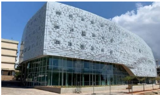
Figure 50: Façade ouest du « The Check Point Building »
