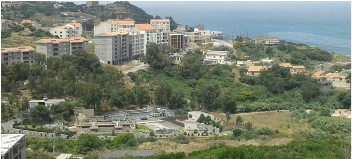
Figure2 : vu général de la station
