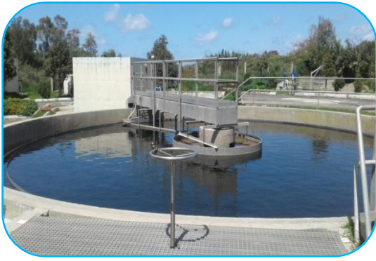
Figure13 : clarificateur
