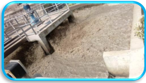
Figure 10 : bassin de nitrification
