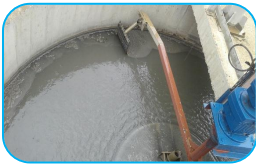
Figure 7 : bassin déshuilage-dessablage
