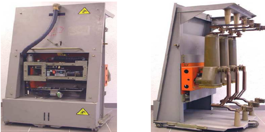
Fig. II.10- Disjoncteur Fluarc FB.4 à commande en plastron.
