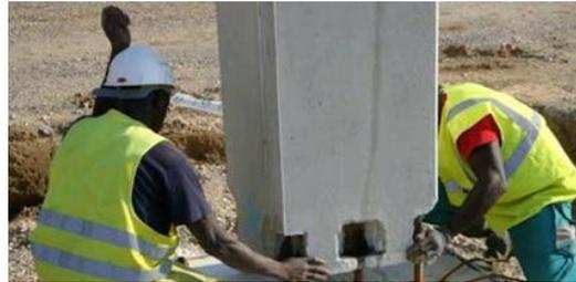
Fig.III.19 : mise en place du poteau en béton armée préfabriqué
