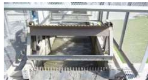
Figure n° 03 : Dégrillage fin
