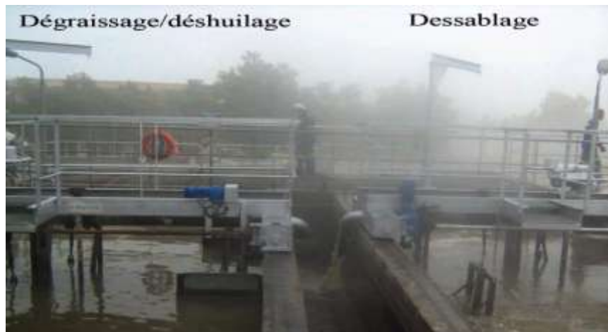
Figure n° 04 : Dessablage et Déshuilage
