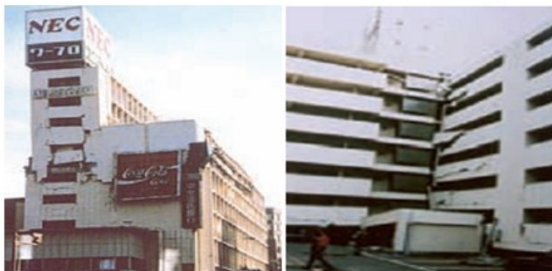
FIGURE 2.15 – Dommages dus à la présence des décrochements.
