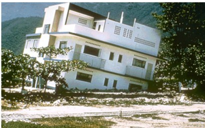
FIGURE 2.9 – Ruine du bâtiment après liquéfaction du sol d’assise
