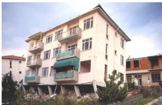
FIGURE 2.13 – Effondrement sous l'effet d'un rez-de-chaussée " souple "
