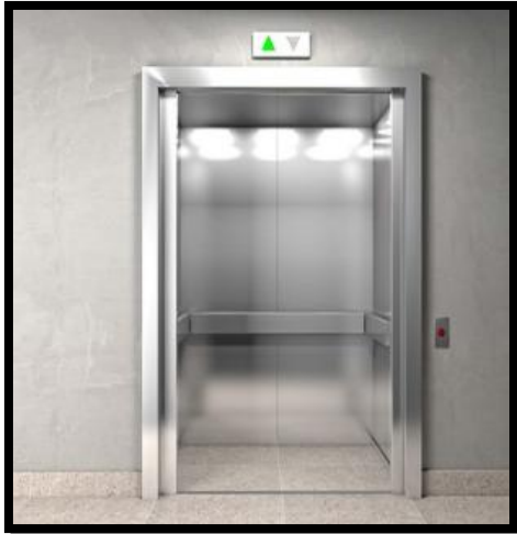
Fig188: vue sur l'ascenseur. Source: auteur.
