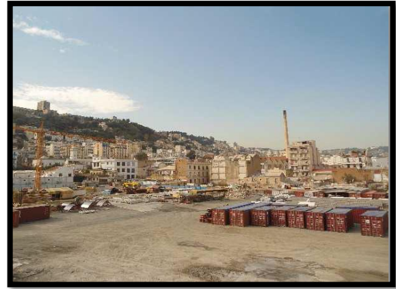
Fig55: hangars et habitat en état de vétusté. Source : auteur
