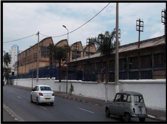
Fig54: Anciens Hangars ferrés en état de vétusté. Source auteur
