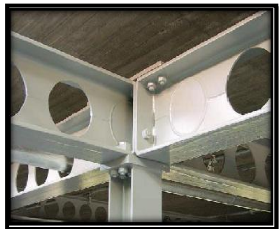
Fig172: assemblage par boulonnage. Source: http://detailsconstructifs.cype.fr
