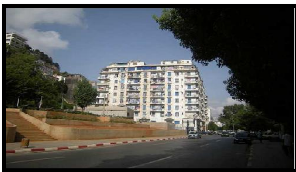
Fig34: vue sur le boulevard MOHAMMED BELOUZDAD
