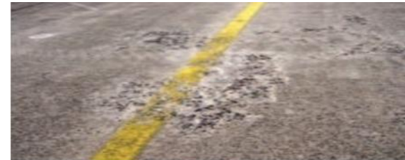
Ecaillage Niveau de gravité élevé.
