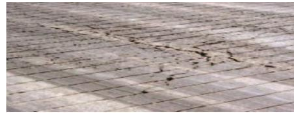
Faïençage: Niveau de gravité léger.
