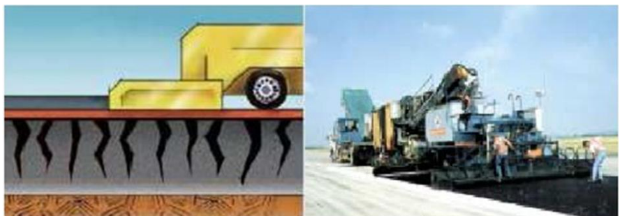
Figure N° VI.10 : Mise en place du recouvrement bitumineux.
