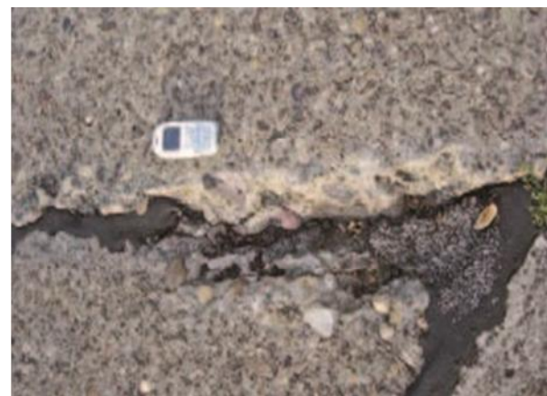
Épaufrure à niveau de gravité élevé (départ de matériaux).
