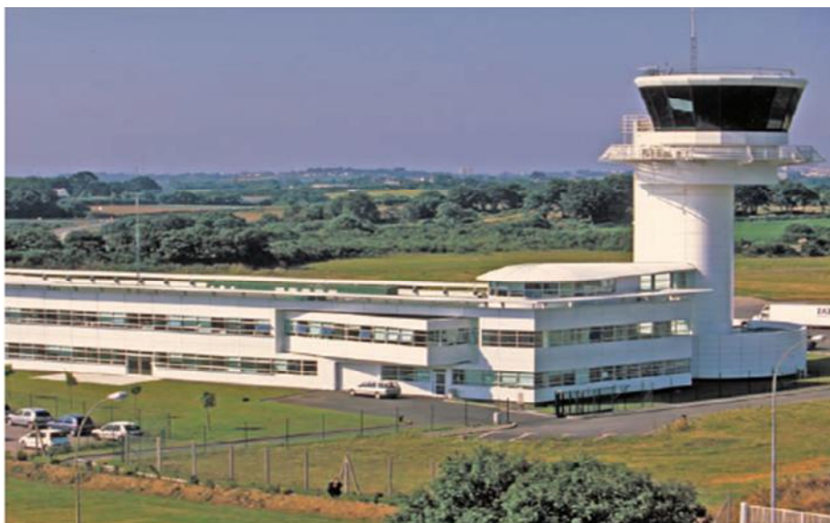
Une tour de contrôle (vigie + fût) - BREST-GUIPAVAS
