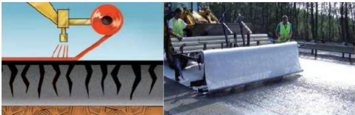
Figure N° VI.9: Mise en œuvre des rouleaux de géogrille.
