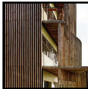
Figure 82 : Vue sur les protections solaires utilisées dans le projet
