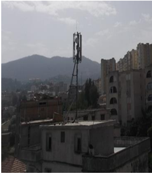
Figure III.7 : un MAT installées sur un bâtiment.
