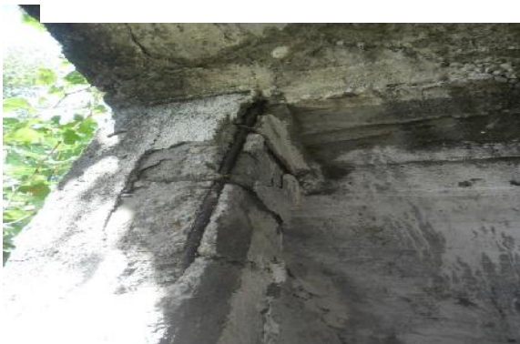
Fig III.16-2: Cisaillement des poteaux. (CHERGUIL.2016) Fig III.16-3: Fissuration des murs. (CHERGUIL.2016)
