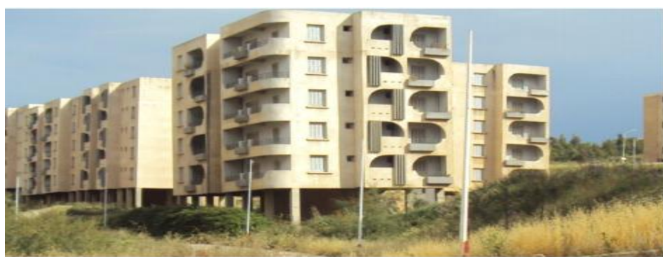
Fig III-61 : Basculement du bloc 5
