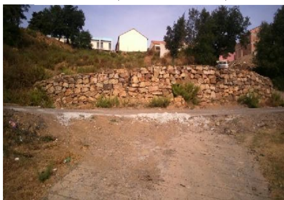
Fig III.14.1 : Arrachement d'une partie de la cour de l'école primaire. (CHERGUI.2016)
