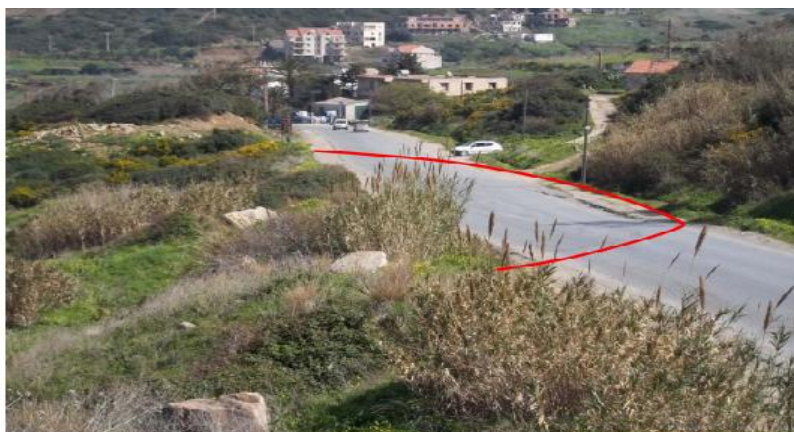
Fig III.1: Glissements Est de Tizirt. (Rapport C .2011 ; Etude des glissements de terrain de Tizirt).
