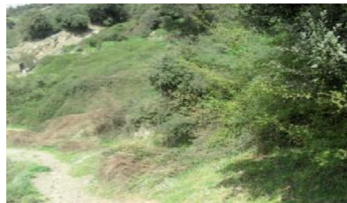
Fig. III.22. Arrachement du sol.
