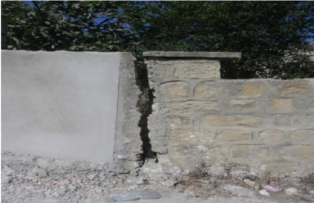
Fig III.10-1 : Ouverture moyenne d'un joint de rupture. (CHERGUI.2016)
