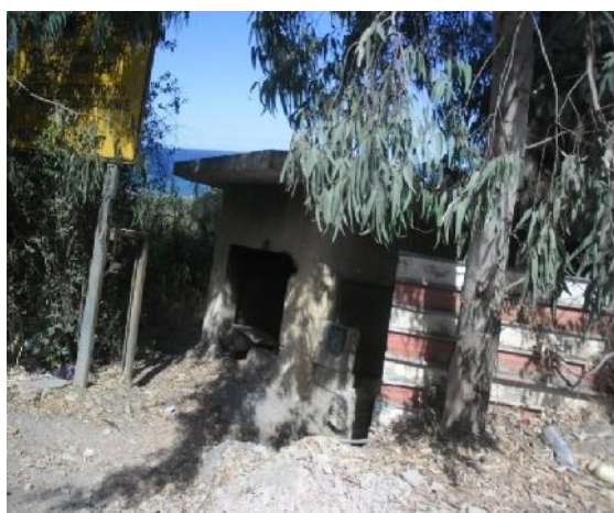
Fig III.10-9 : Inclinaison d'une baraque. (CHERGUI.2016)
