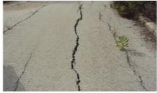
Fig III-57 : Affaissement important
