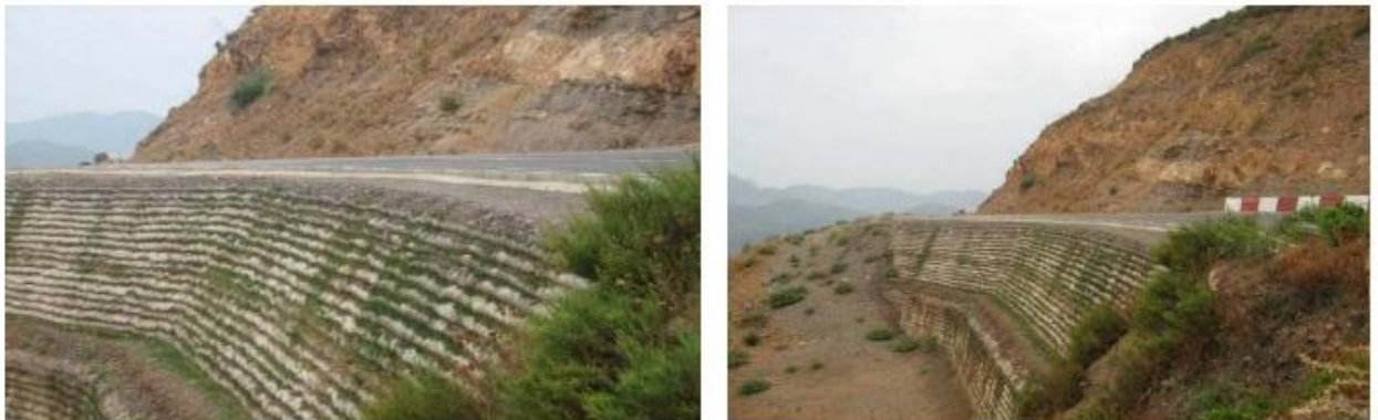
Figure III.107-b : ouvrage après son achèvement. (BENDJEDDOU.2015)
