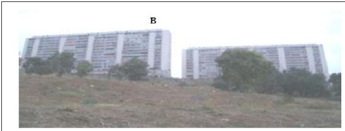
Figure II.30 : Immeubles du site Ciloc affecté par le glissement, (au pied du bâtiment B). (BOUDLAL 2013)
