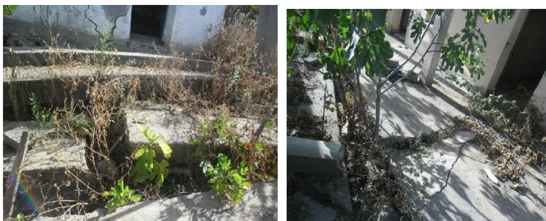
Fig III.15-6 : Soulèvement du sol. (CHERGUI.2016)
