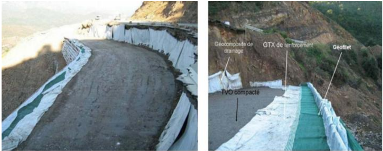
Figure III.107-a : ouvrage pendant la phase des travaux. (BENDJEDDOU.2015)
