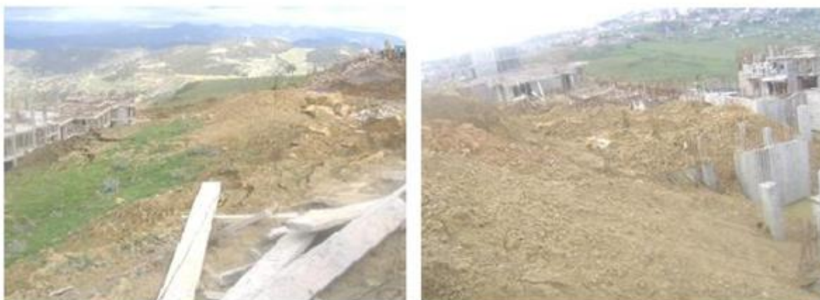
Figure III. 93: Glissements de terrains, zone des 400 logements de l'OPGI, (Médéa). (BOUDLAL.2013)
