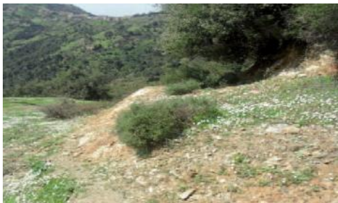
Fig. III. 21. Affaissements du terrain.
