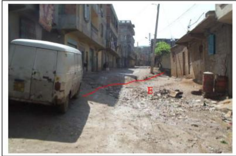
Fig III.41: Glissement du bas quartier de Boudraa, avec escarpement bien apparent de tête de glissement (E). (BOUGDAL.2007)
