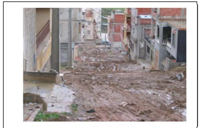
Fig III-72 : Les terrassements excessifs et l'absence de drainage efficace, constitue une véritable menace pour ces constructions. (BOUGDAL.2007)
