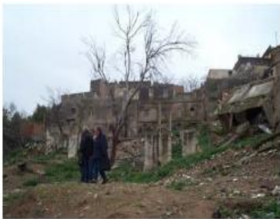
Fig III.51 : Dégradation du Bâti dans le quartier des Maquisards. (BOUGDAL.2007)
