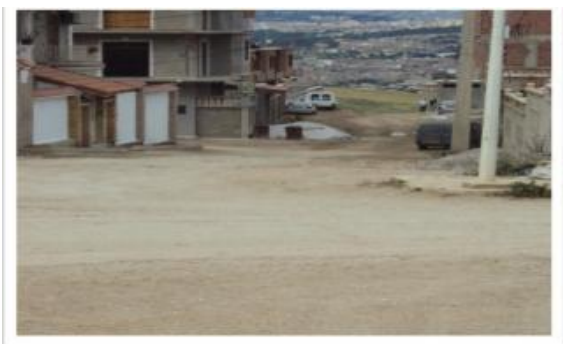
Fig III-68 : Affaissement de la rue et les revêtements des trottoirs
