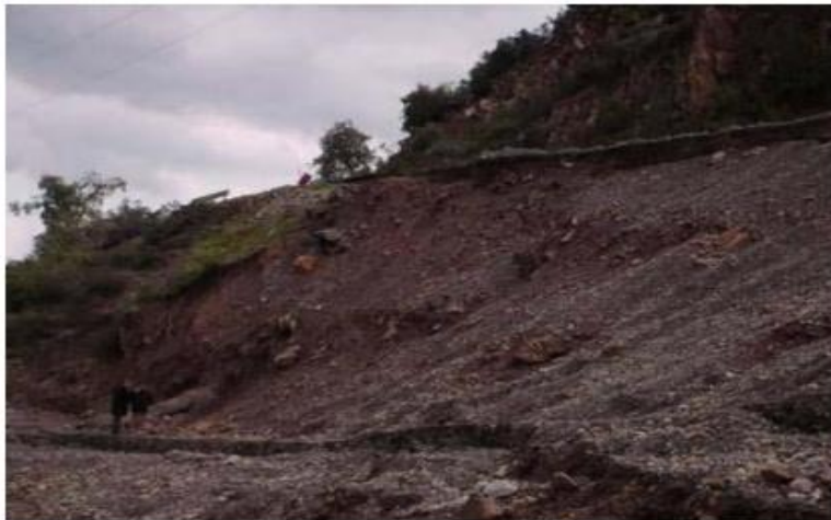
Fig III.100 : vue générale du glissement. (BENDJEDDOU.2015)
