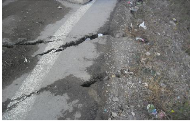
Fig III.9 : Dégradation et fissuration de la chaussée. (CHERGUI.2016)
