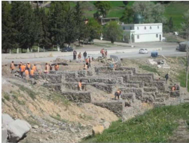
Fig III-96 : déroulement des travaux de confortement. (DJENBA.2015)
