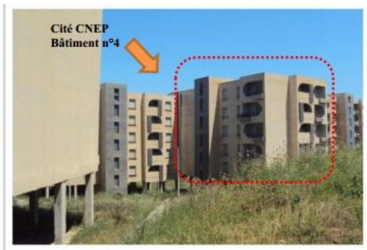
Fig III-55 : bâtiment n°4 dans la cité CNEP 150 Logements.
