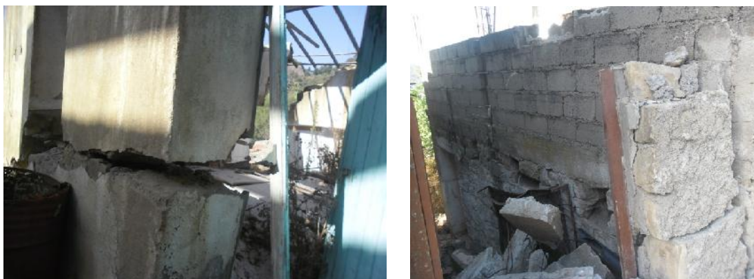
Fig III.15-4 : Cisaillement des poteaux. (CHERGUI.2016)
