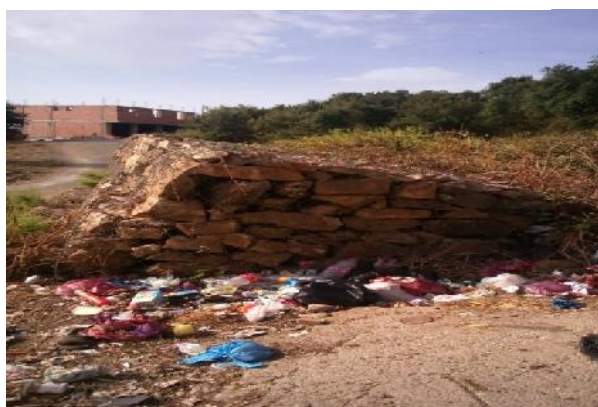
Fig III.14.1 : Arrachement d'une partie de la cour de l'école primaire. (CHERGUI.2016)
