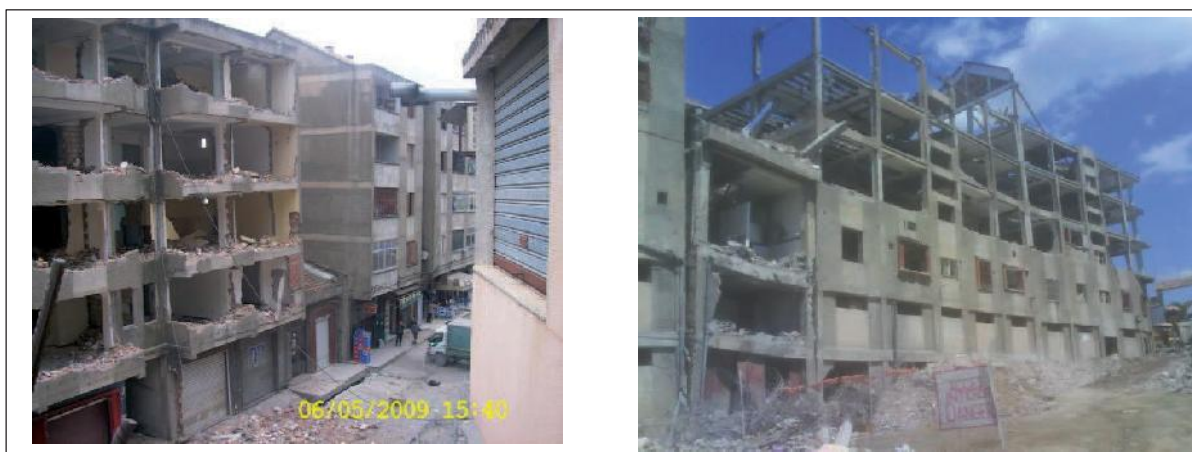
Fig III-31-3 : Démolition des Immeubles APC/CNEP N° 14 et 15.
