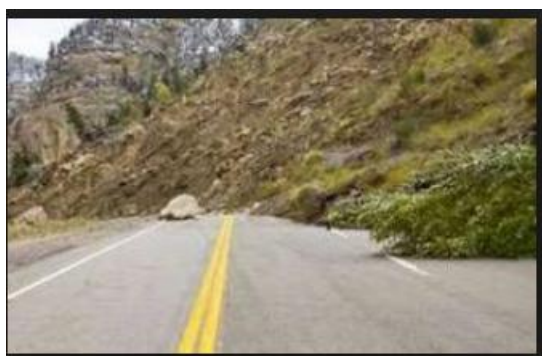
Fig III.39-9 : Escarpement sur la route nationale N° 9
