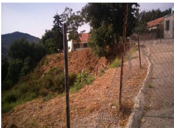
Fig III.14.1 : Arrachement d'une partie de la cour de l'école primaire. (CHERGUI.2016)
