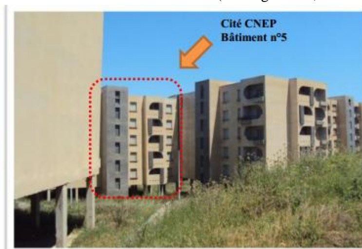
Fig III-60 : Bâtiment n°5 dans la cité CNEP 128 Logements
