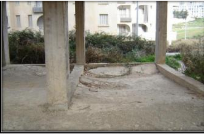
Fig III-62 : Affaissement de la plate-forme du bloc5
