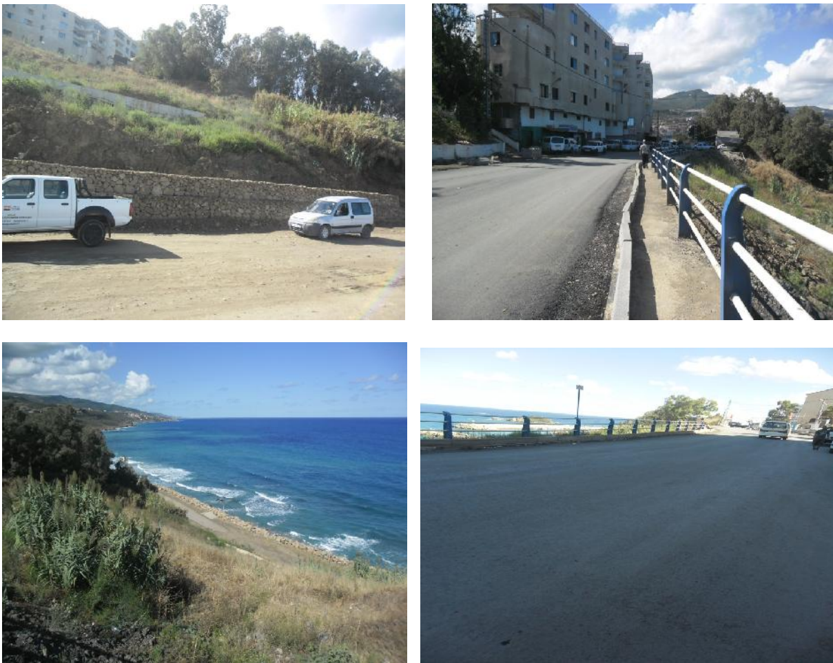
Fig III.11-4 : glissement après achèvement des travaux. (CHERGUI.2016)
