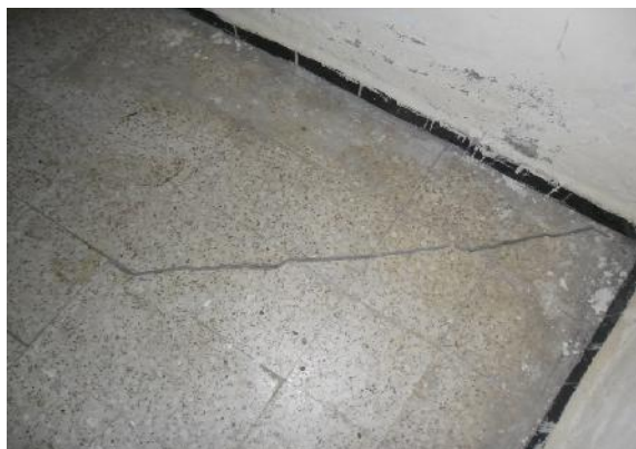
Fig III.16-4: Fissuration du carrelage. (CHERGUIL.2016) Fig III.16-5: Soulèvement du carrelage (CHERGUIL.2016).
