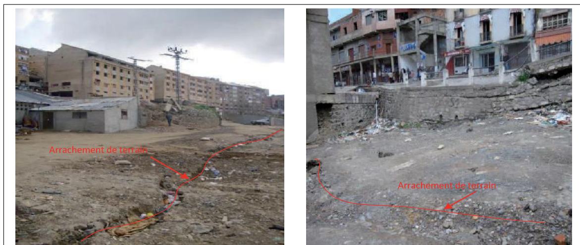
Fig III-31-6: L'arrachement de terrain observé en aval de l'immeuble Taleb (menuiserie).
