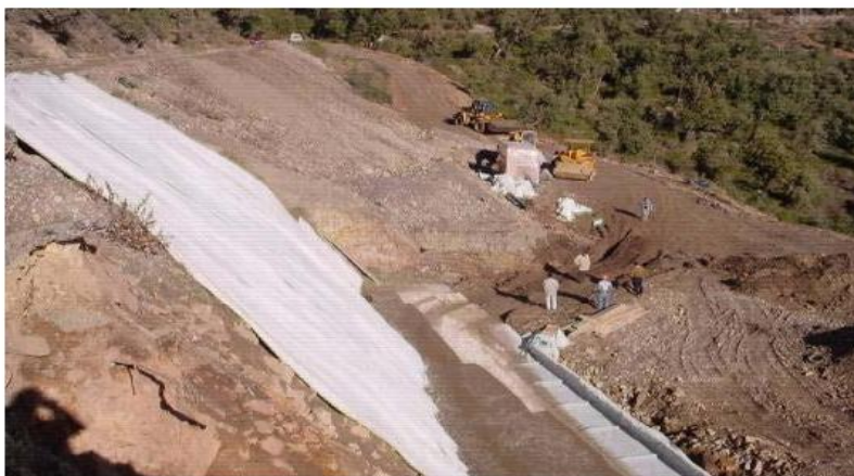
Fig III.105- a : vues de l'ouvrage en cours de construction. (BENDJEDDOU.2015)
