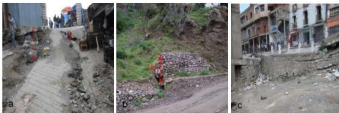
Fig III-28 : Les déformations dans la ville de Ain El Hammam. (Djeral et Melbouci, 2012)
