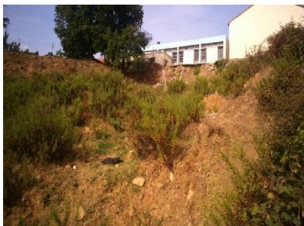
Fig III.14.1 : Arrachement d'une partie de la cour de l'école primaire. (CHERGUI.2016)
