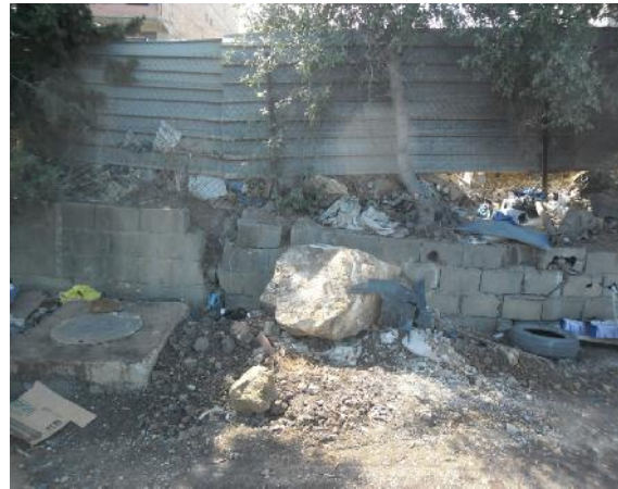
Fig III.10-11 : Dégradation d'un mur en maçonnerie(CHERGUI.2016).
