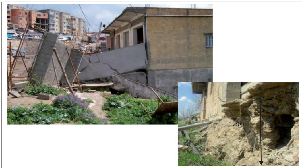
Fig III-31-8: Vue globale de l'immeuble Taleb Gozali.
