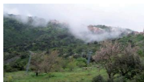
Fig. III.24. Pilonnes électriques inclinés.
