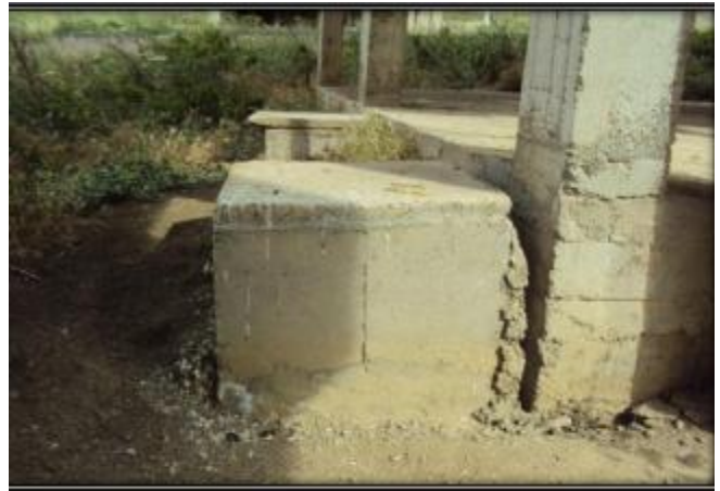
Fig III-63: Déplacement au niveau des regards
