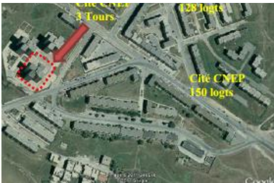
Fig III-64: Vue aérienne sur la localisation de la Tour du CNEP. Google earth ; 2011.
