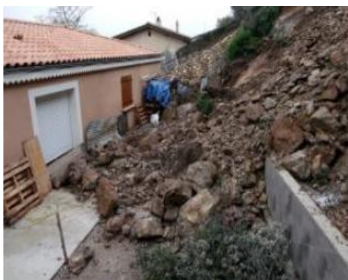
Fig III.39-3 : Désordre au niveau d'un établissement scolaire
