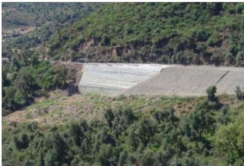
Fig III.105-b vues de l'ouvrage après son achèvement . (BENDJEDDOU.2015)
