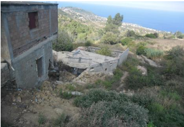
Fig III.13-1: constructions récentes en ruine(CHERGUI.2016).
