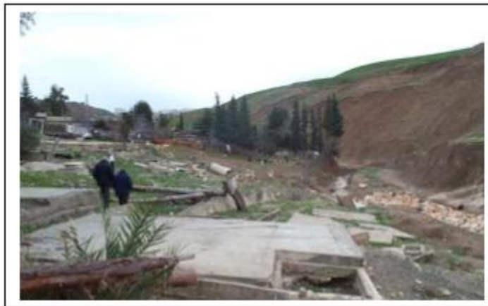
Fig III.40 : Fondations sur radiers basculés de la cité SOTRACO, désaffectée. Chabet el Merdja (BOUGDAL.2007)
