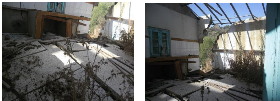
Fig III.15-3 : Soulèvement de carrelage. (CHERGUI.2016)
