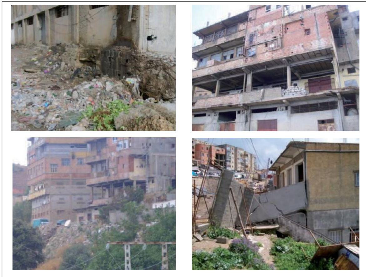
Fig III-31-5: Images de quelques habitations affectées par le mouvement de terrain.
