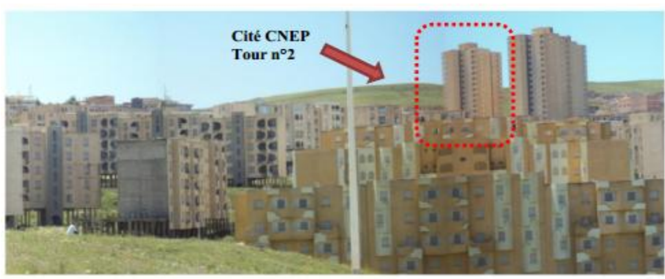
Fig III-65 : les trois Tours du CNEP.
