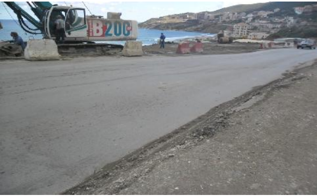
Fig III.9 : Dégradation et fissuration de la chaussée. (CHERGUI.2016)
