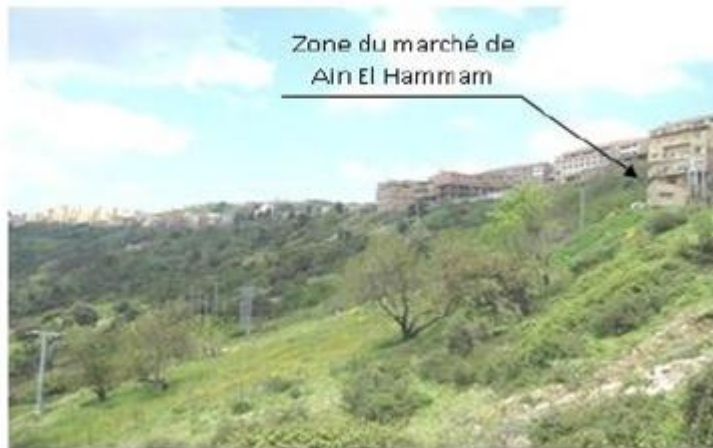
Fig II.06 : Zone instable du marché d'Ain-EL Hammam. (BOUDLAL.2013)
