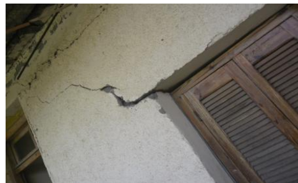
Fig III.16-2: Cisaillement des poteaux. (CHERGUIL.2016) Fig III.16-3: Fissuration des murs. (CHERGUIL.2016)
