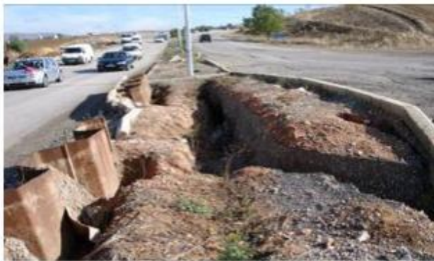
Figure III.82 : présence de faille au niveau de la route
