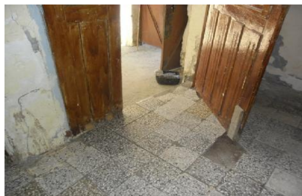
Fig III.16-4: Fissuration du carrelage. (CHERGUIL.2016) Fig III.16-5: Soulèvement du carrelage (CHERGUIL.2016).
