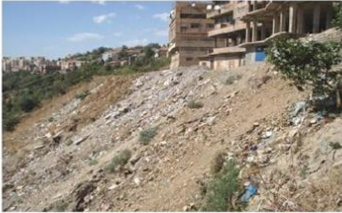
Figure III. 32 : remblais jetés à la partie Ouest de la zone du marché
