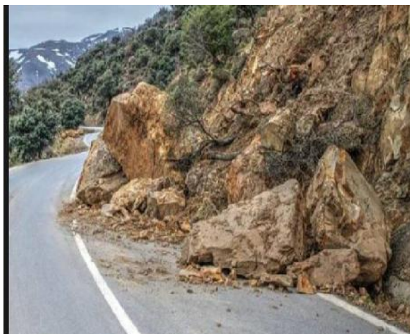
Fig III.39-6 : Chut de blocs
