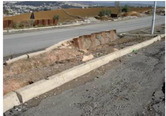
Figure III.83 : Palplanches ancrées dans le milieu de l'axe de la route
