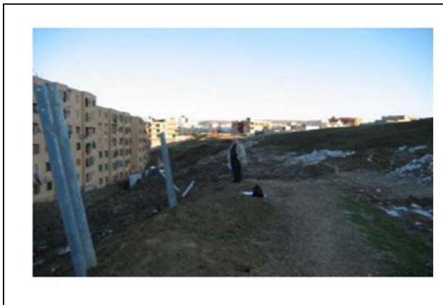
Fig III.71: un glissement a détruit une route et a envahi un RDC de deux bâtiments situés en contrebas. (BOUGDAL.2007)
