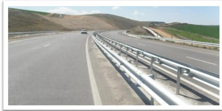
Figure VIII.3 : Glissières métalliques sur TPC, et sur accotement.
